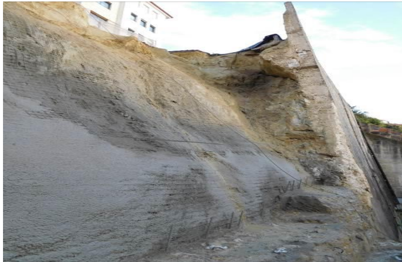
Figura 3.4 - Revestimento do talude com betão projetado (JETSJc, 2017)
