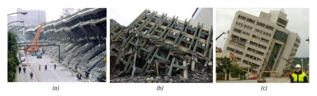
Figura 1.1- Estruturas que não apresentaram capacidade suficiente para resistir ao sismo (a) - Viaduto da "Hanshin expressway", Kobe, 1995. (b) - Equador, 2016. (c) - Taiwan, 2018.
