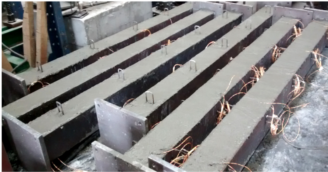
Figura 3.3 - Pilares concretados em um dos lados.
