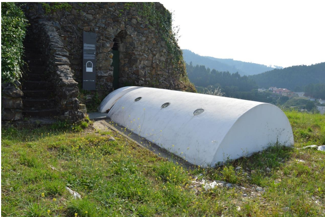
Fig. 44 - Antiga cisterna do Castelo de Miranda do Corvo
