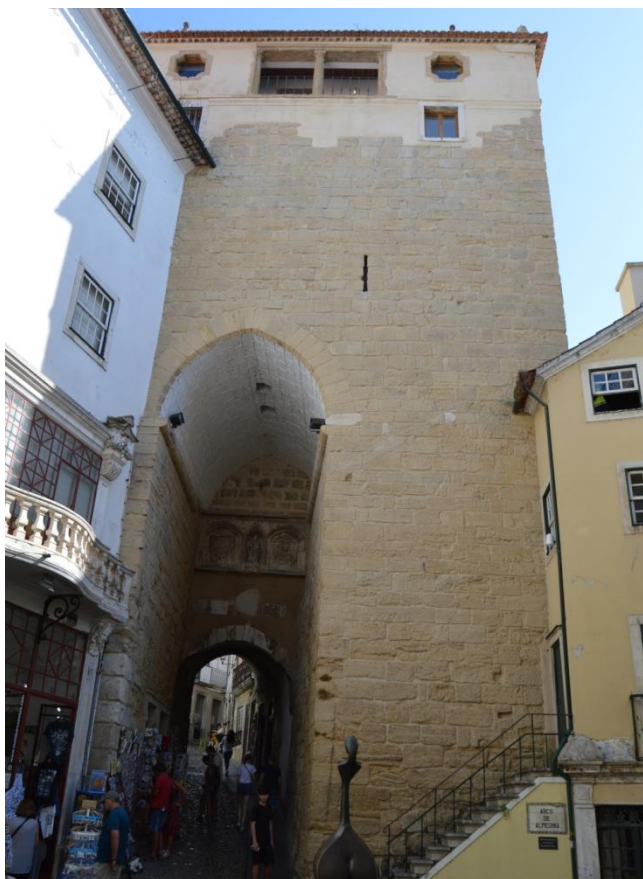
Fig. 11 - Torre de Almedina
