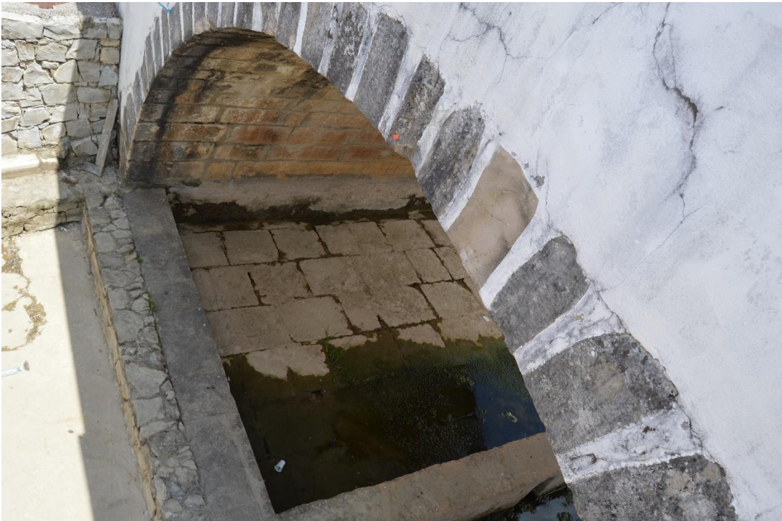
Fig. 8 - Tanques dos Banhos Santos
