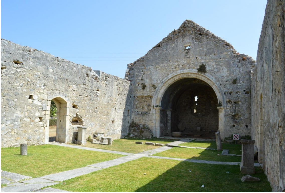
Fig. 79 - Igreja da Finisterra de Vila Nova de Anços
