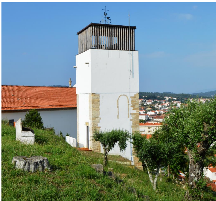
Fig. 45 - Torre de canto pertencente ao Castelo de Miranda do Corvo
