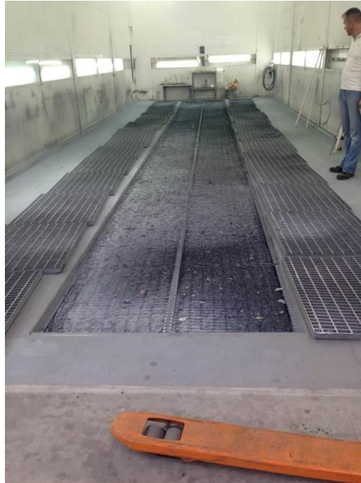
Figura 30C - Retirar os Filtros de Chão usados
