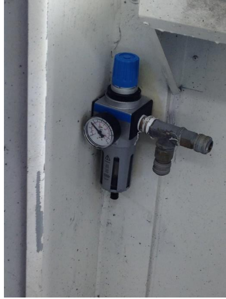
Figura 29C - Tarefas realizadas para a instalação de um Filtro Regulador
