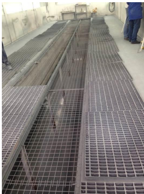
Figura 31C - Lavagem das Grelhas
