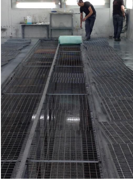
Figura 32C - Colocação dos novos Filtros de Chão
