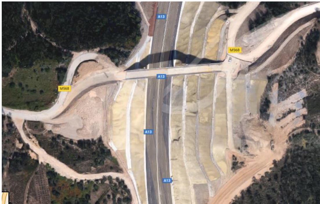
Figura 3.1 – Vista em planta da PS3 e do talude em estudo (direção sul-norte). Imagem retirada do Google Maps (2017).
