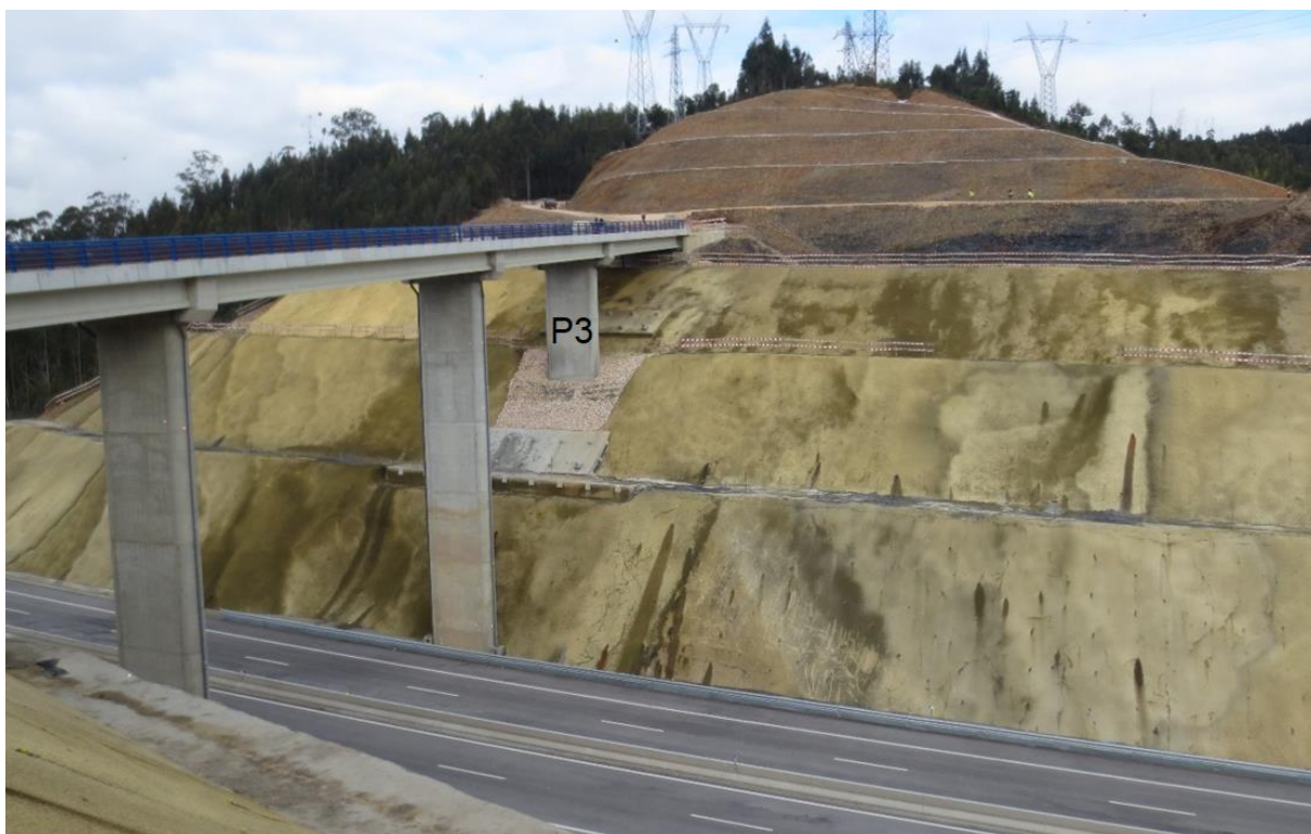
Figura 3.2 – Fotografia do talude em estudo a sul da PS3 (depois da estabilização).
