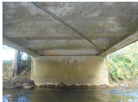
d) Vista face inferior tabuleiro
