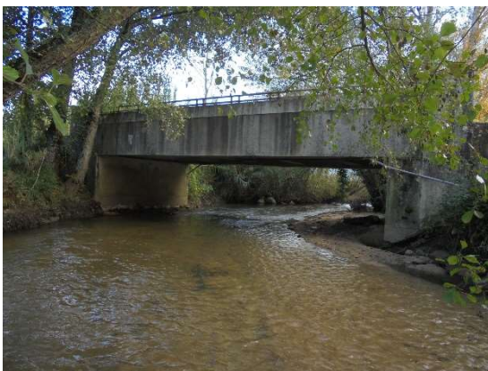
c) Vista de montante
