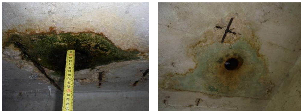
a) Drenagem direta para laje de tabuleiro lado jusante sul
