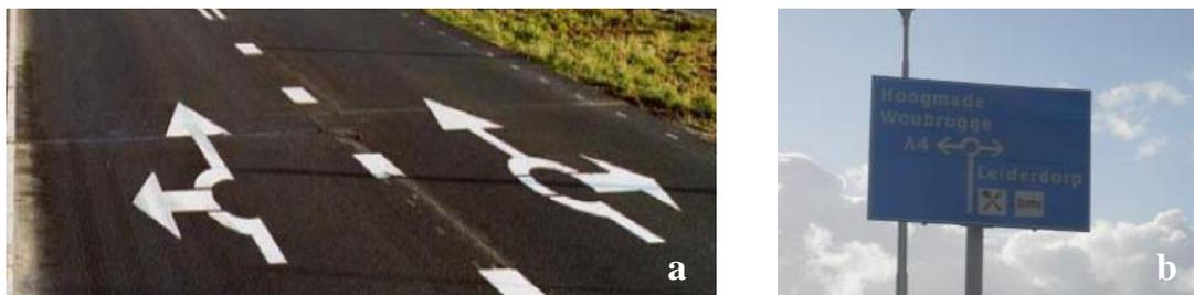
Figura 2.3 - (a) setas de seleção; (b) painéis de pré-aviso gráfico (Bastos Silva et al, 2013).
