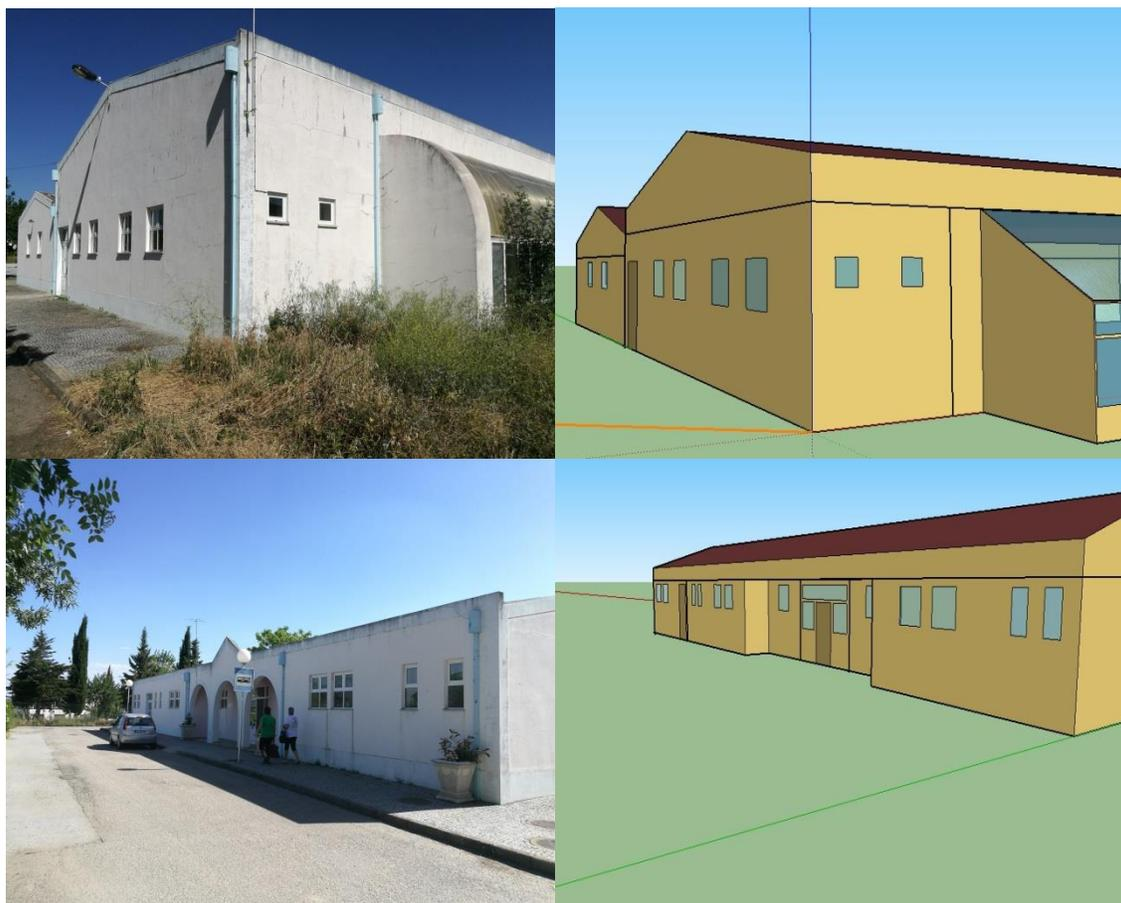
**Fig. 3.2 - Fotografia real vs. modelo de simulação (vista Norte e Este)**
