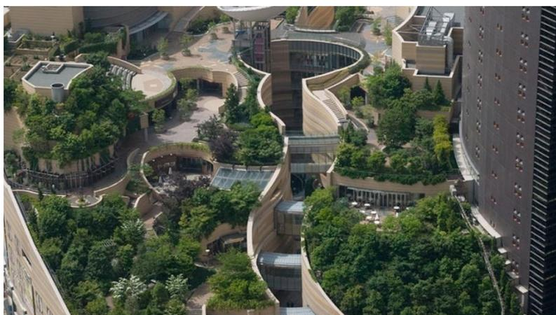
Figura 2.2 – Cobertura verde intensiva (retirado de FV@, 2017).
