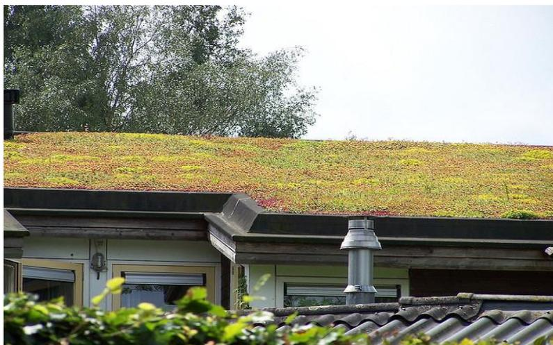
Figura 2.3 – Cobertura verde extensiva (retirado de PV@, 2017).
