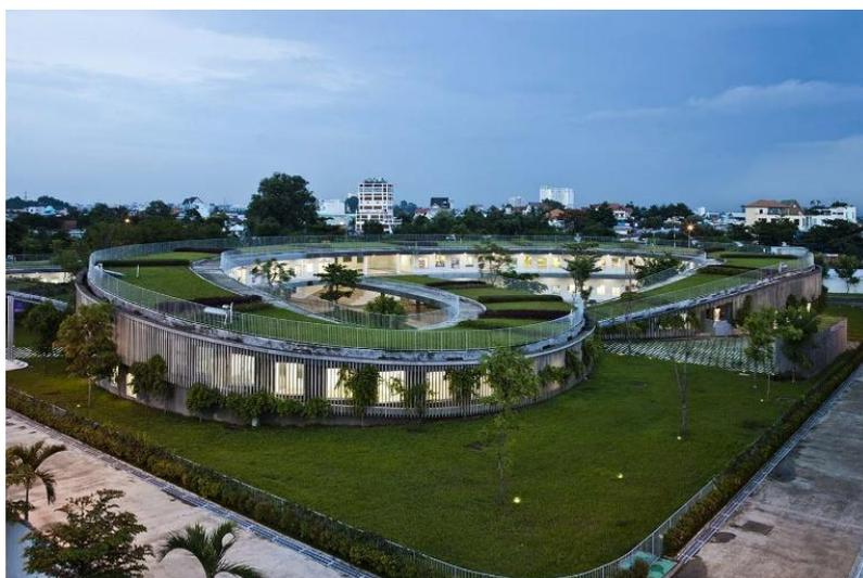
Figura 2.4 - Cobertura verde semi-intensiva (retirado de EC@, 2017)
