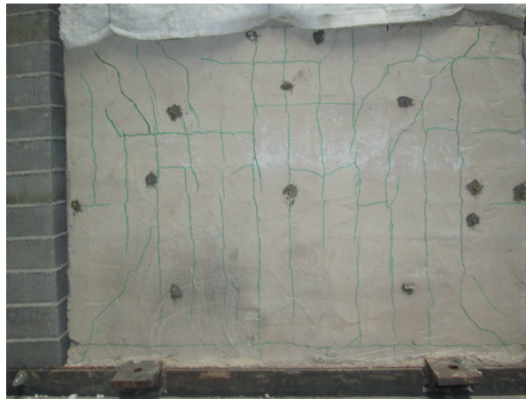
Figura 3.34 - Provetes 2 – Padrão de fissuração na face não exposta
