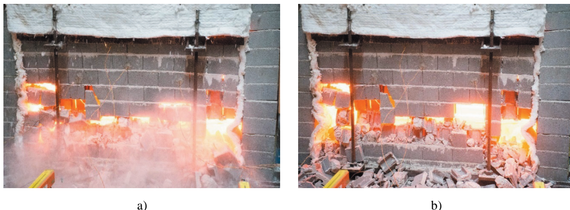
Figura 3.40 - Provete 6 - Sequência de colapso estrutural - 2 de 2
