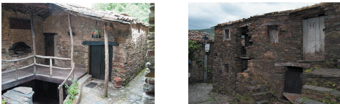
Figura 1.2 - Alvenaria de Xisto - Pormenores de inserção de padieiras e vigas em madeira nas paredes – Talasnal, Portugal
