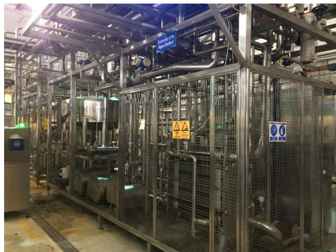
Figura 5.3 Vista parcial da Plataforma
