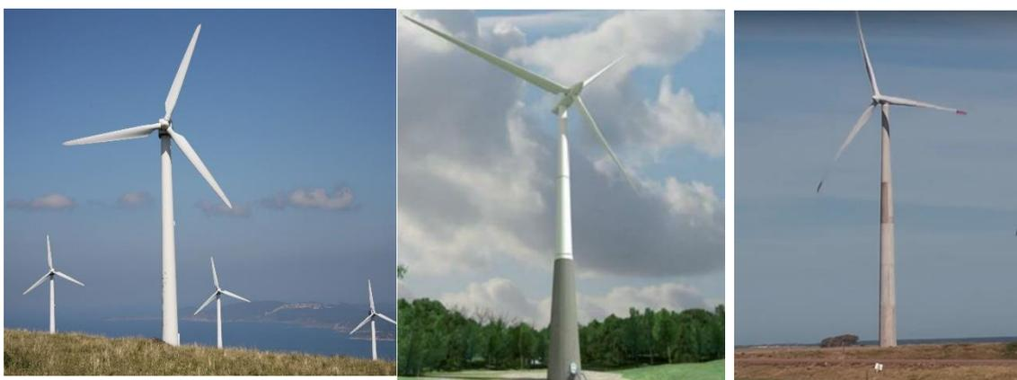
Figura 2.12– Exemplos de alguns dos tipos de torres existentes. À esquerda, de aço (<http://www.clean-energy-ideas.com>), ao meio, mista (<https://www.researchgate.net>) e à direita, de betão pré fabricado (<https://www.acciona.com>).
