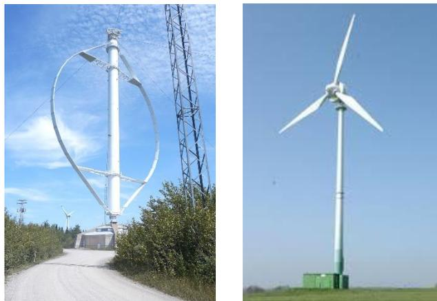
Figura 2.6– À esquerda: rotor de eixo vertical (<http://www.dinamicambiental.com.br>); à direita: rotor de eixo horizontal (<http://www.aneel.gov.br>).
