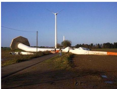
Figura 4.2– Derrube de torre eólica devido a dimensionamento incorreto da fundação (<http://www.windcows.com>).
