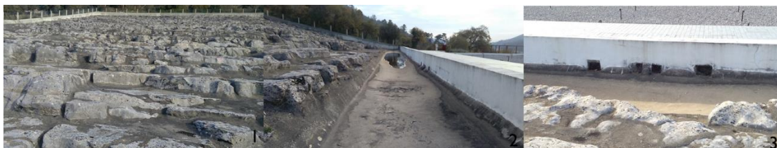
Figura 2 - "Barragem" de Serro Ventoso - Aproveitamento de AP para consumo humano – 1: eira; 2: caleira; 3: entrada de água para o tanque de captação
