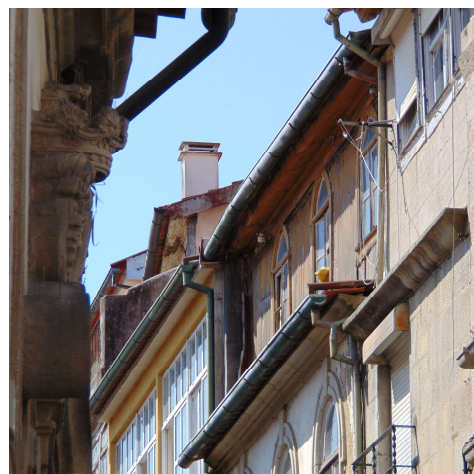
Figura 5.13 – Piso recuado sobre cornija. Beirado forrado sobre caibros.
