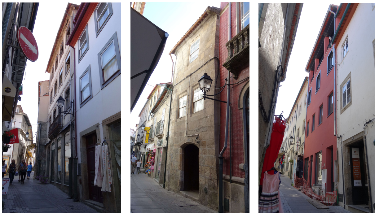
Figura 5.16 – Edifícios analisados na Rua Direita (n.º173, n.º143 e n.º275 respetivamente)
