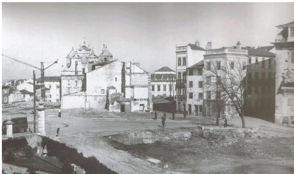
Figura 2.2 – Demolição do Largo do Castelo, atual Praça D. Dinis, Coimbra
