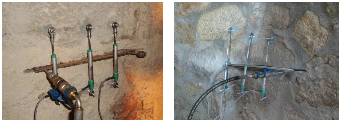
Figura 4.20 – Realização do ensaio de macacos planos simples, no edifício do Orfeão de Viseu (à esquerda), e no edifício das Águas de Viseu (à direita)
