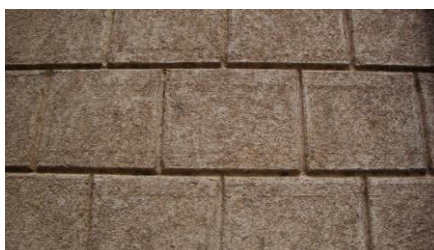
Figura 4.11 – Fingidos de pedra na fachada do rés-do-chão
