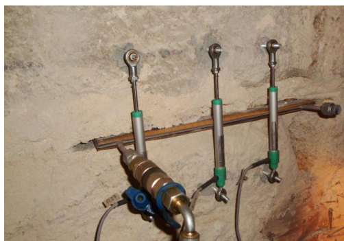
Figura 4.1 – Ensaio de macacos planos numa parede de alvenaria
