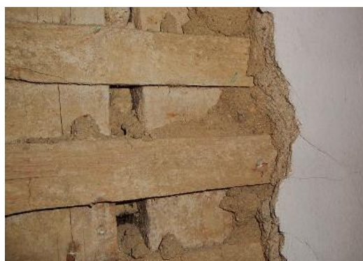
Figura 4.8 – Paredes divisórias em tabique de madeira
