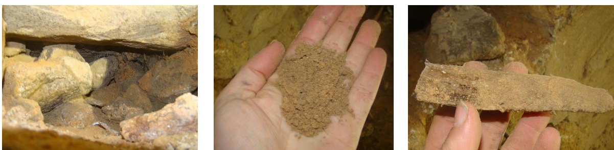
Figura 4.29 – Núcleo interior da parede observada (Águas de Viseu)
