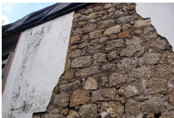
Figura 3.2 – Paredes de alvenaria em centros urbanos antigos portugueses
