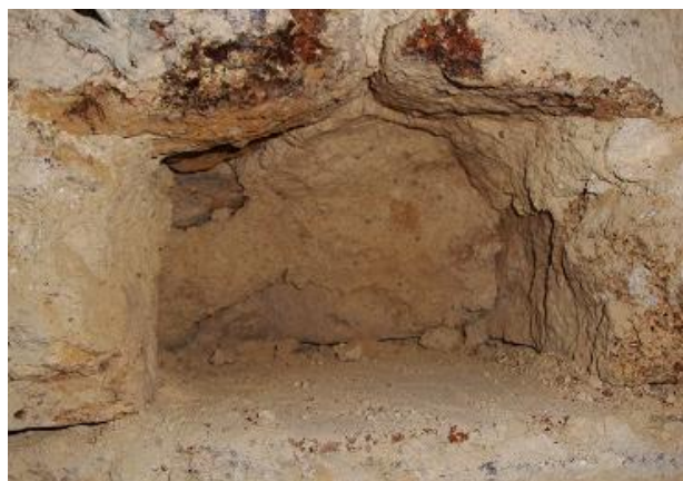
Figura 4.28 – Secção transversal da parede observada (Orfeão de Viseu)
