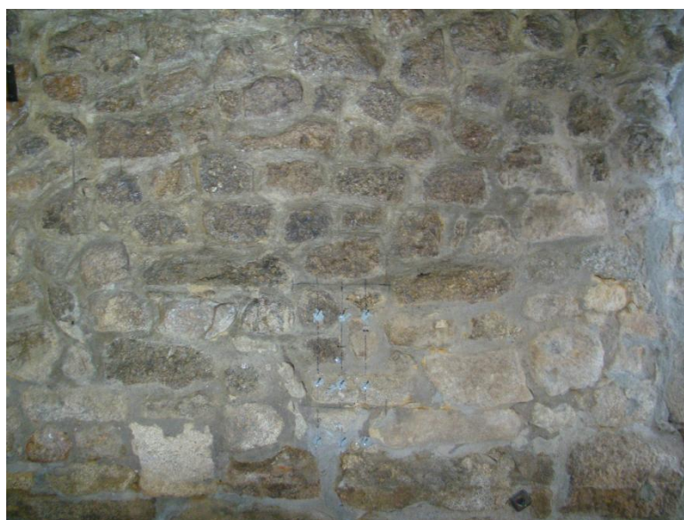
Figura 4.13 – Parede caracterizada no edifício das Águas de Viseu
