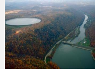
PHS de 3000 MW, com uma diferença de elevação entre reservatórios de 385 m (Virgínia, USA)
