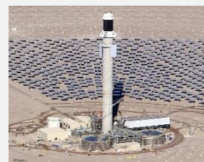
Torre atingida por raios solares, aquecendo o sal fundido. Capacidade de 110 MW (Nevada, USA)
