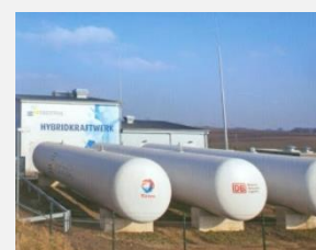
Tanques de 2.400 m 3 a 200 bar, com 55 kW de hidrogénio usado para
