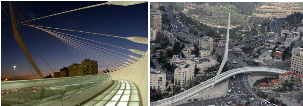
Figura 20 - Chords Bridge, Jerusalém (Stankiewicz, et al., 2015)
