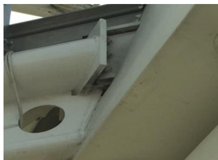
Figura 32 - Ligação aparafusada da ponte ao pavimento lateral
