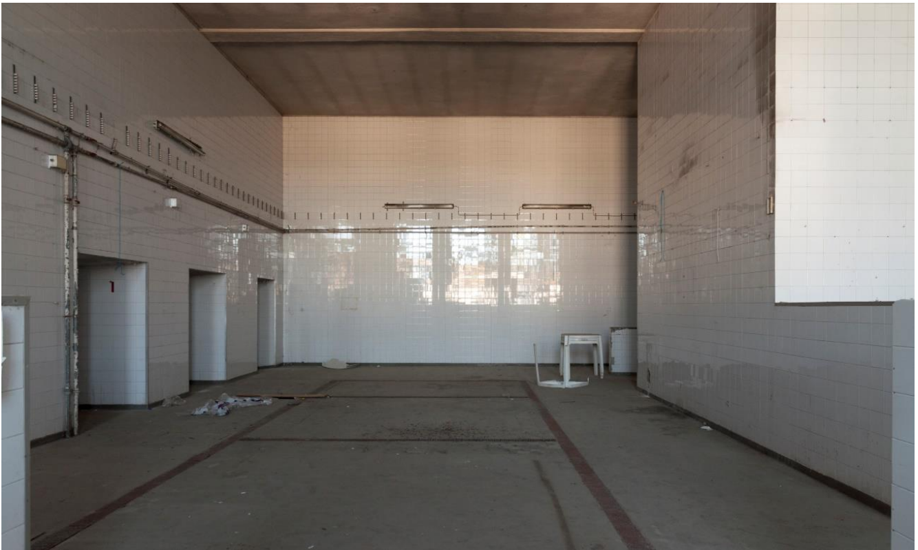
Figura 91 - Ala poente do Mosteiro de Santa Clara-a-Nova. Fotografia de Jorge das Neves. Fonte: CAPC.
