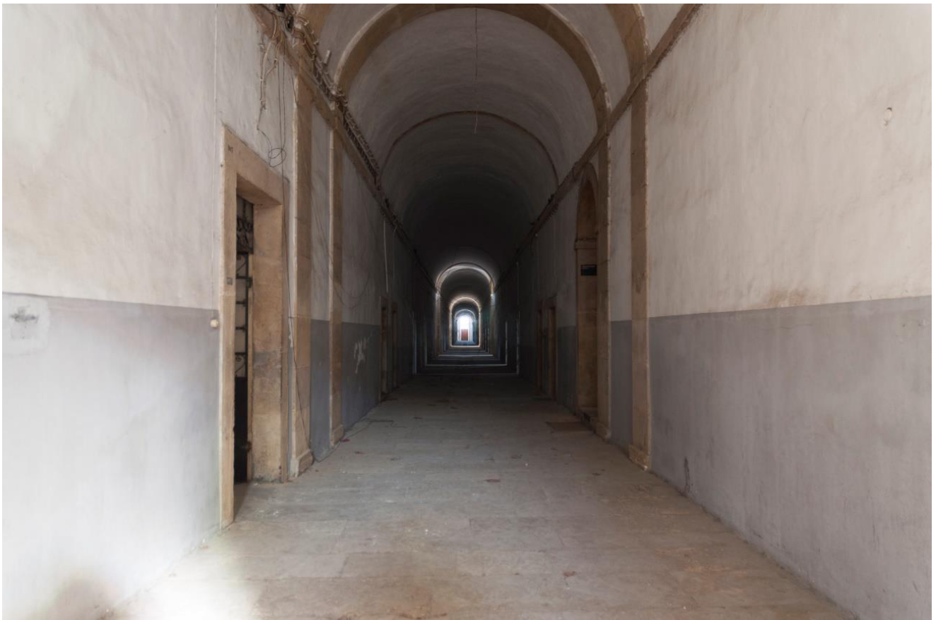
Figura 82 - Corredor Central do Mosteiro de Santa Clara-a-Nova. Fotografia de Jorge das Neves. Fonte: CAPC.
