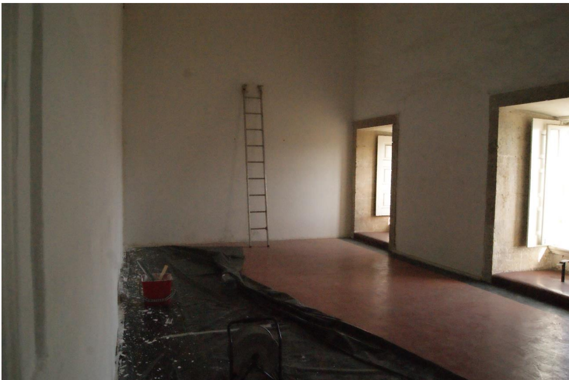
Figura 257 - Montagem da obra "Metal sonante" de Gustavo Sumpta na sala adjacente no piso 1 do Mosteiro de Santa Clara-a-Nova. Fotografia da autora.
