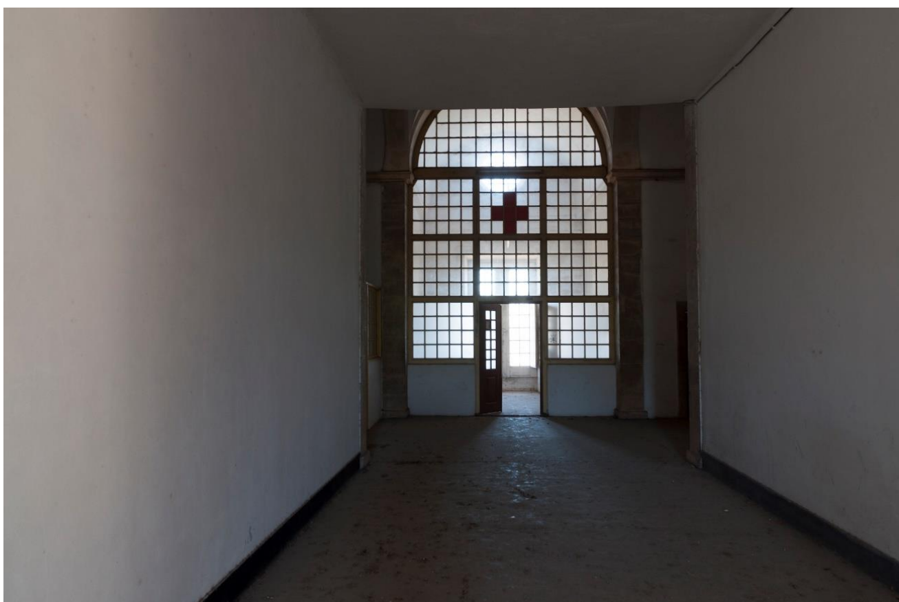
Figura 98 - Corredor central do Mosteiro de Santa Clara-a-Nova. Fotografia de Jorge das Neves. Fonte: CAPC.
