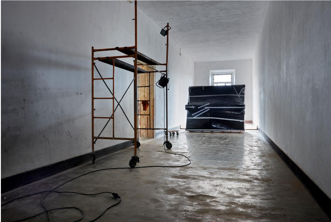
Figura 262 – Montagem da obra "We the people" de Danh Võ na sala adjacente ao corredor central do piso 1 do Mosteiro de Santa Clara-a-Nova. Fotografia de Vitor Garcia. Fonte: CAPC.
