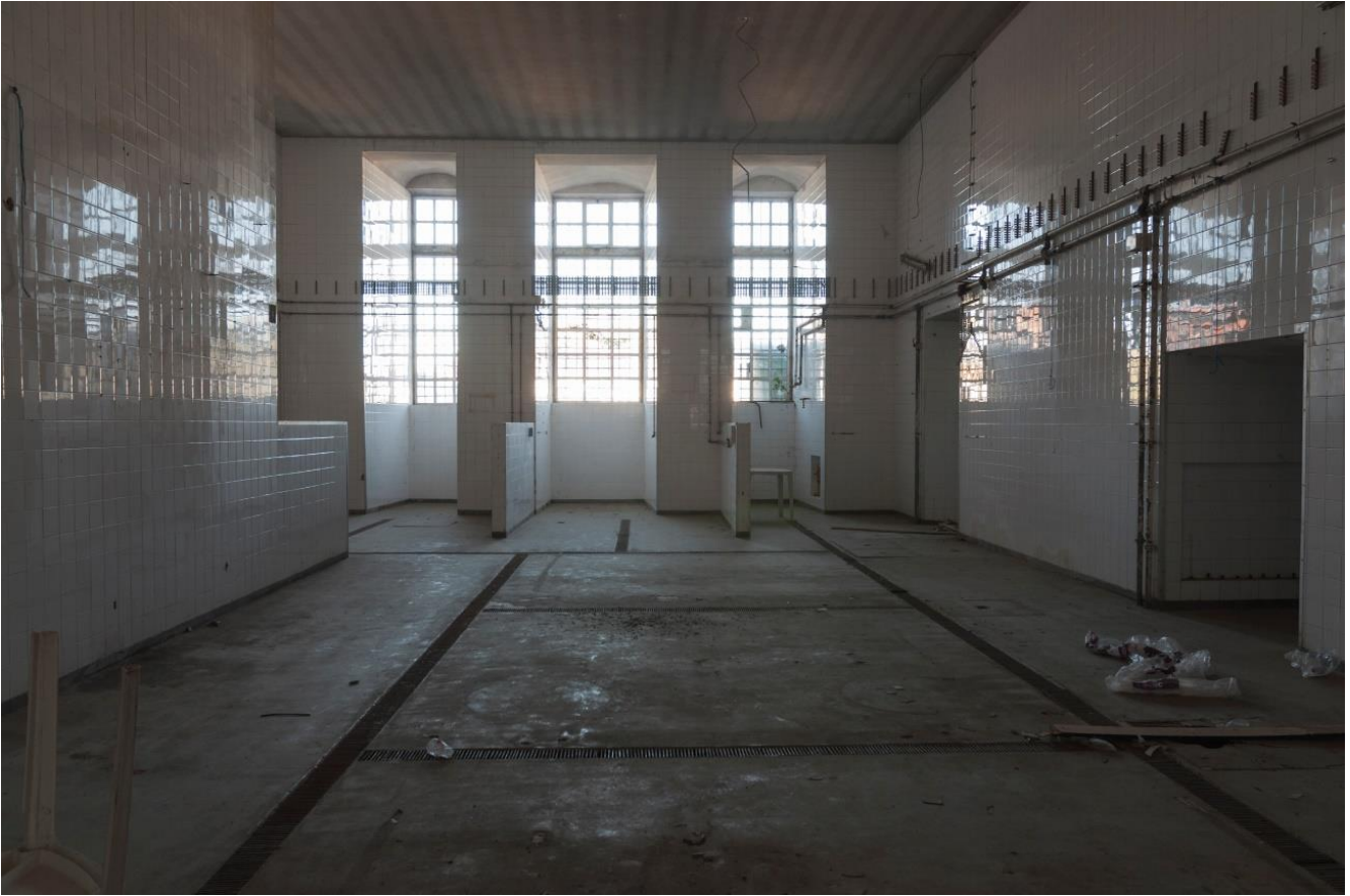
Figura 92 - Ala poente do Mosteiro de Santa Clara-a-Nova. Fotografia de Jorge das Neves. Fonte: CAPC.
