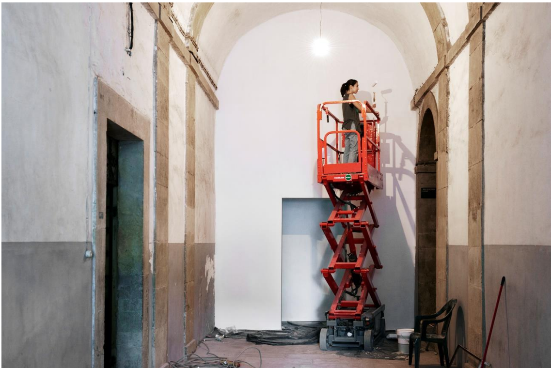
Figura 181 - Montagem da obra "Cura" de Julião Sarmento no corredor central do Mosteiro de Santa Clara-a-Nova. Fotografia de Vitor Garcia. Fonte: CAPC.
