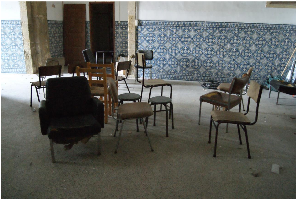
Figura 124- Ala poente antes das limpezas na sala onde se localizou a obra de Ângela Ferreira durante o Anozero '17. Fotografia da autora.
