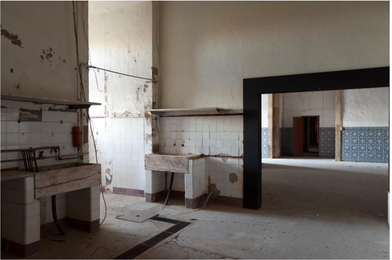
Figura 87 - Ala poente do Mosteiro de Santa Clara-a-Nova. Fotografia de Jorge das Neves. Fonte: CAPC.
