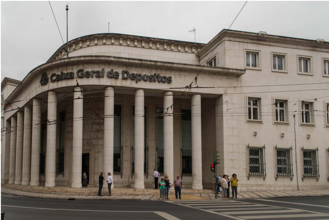
Fig. 13 - Caixa Geral de Depósitos (Coimbra). Arquiteto Veloso Reis Camelo, 1954. (Fotografia de Autor).
