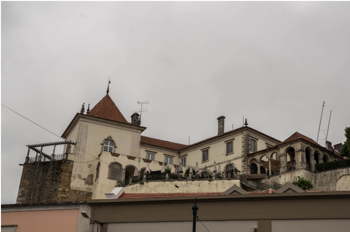
Fig. 7 - Casa Dr. Ângelo da Fonseca (Coimbra). Arquiteto Raul Lino, 1928. (Fotografia de Autor).
