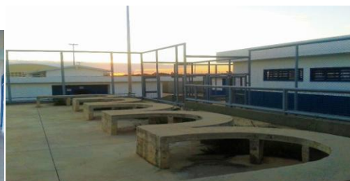
Foto 4 – Área externa dos módulos
