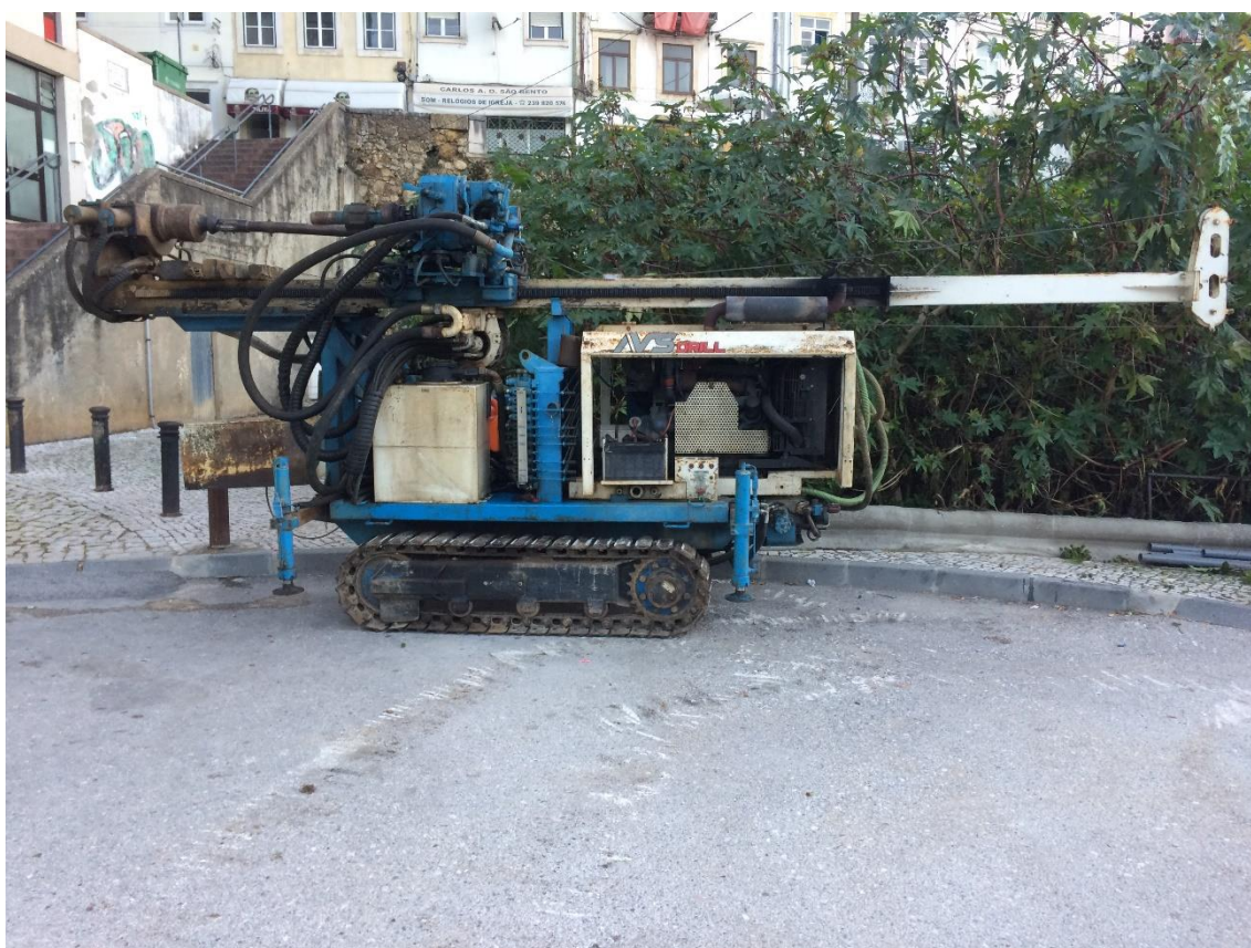
Figura 23 - Equipamento utilizado na execução das sondagens (ELLETARI EK 200).
