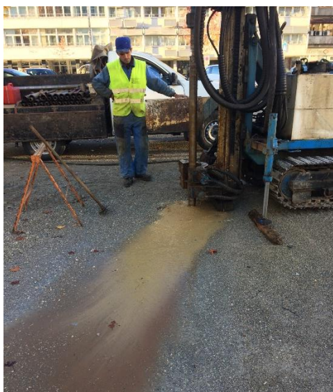
Figura 22 - Trabalhos de perfuração na sondagem S1. De notar a produção de lamas.
