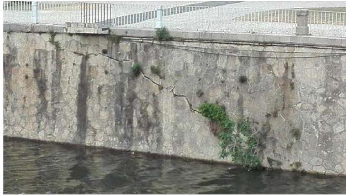
Figura 3 - Muro com fissuras junto à ponte de Santa Clara e consequente crescimento de vegetação.
