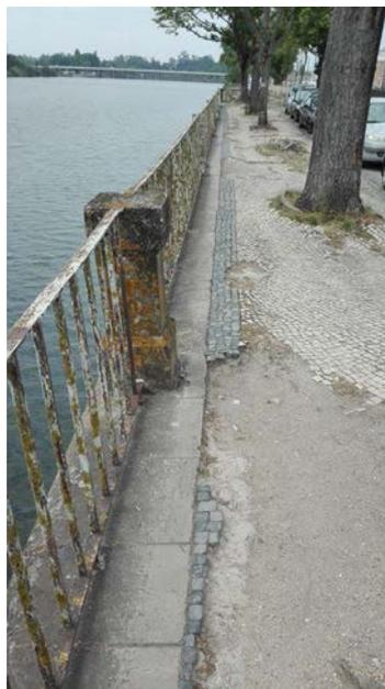
Figura 4 - Passeio com deformações junto à estação Coimbra A.
