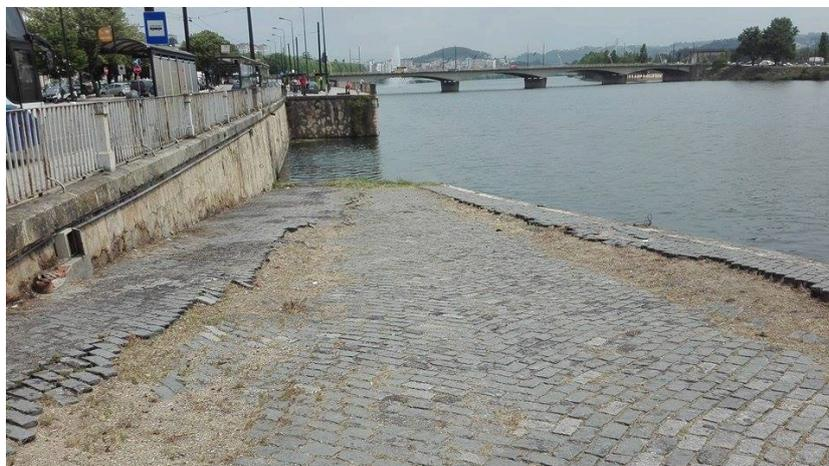
Figura 5 - Rampa na portagem com deformações.
