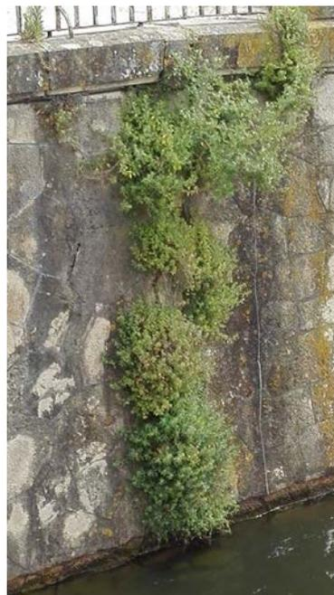
Figura 7 - Vegetação a crescer nas fissuras, junto à estação Coimbra A.
