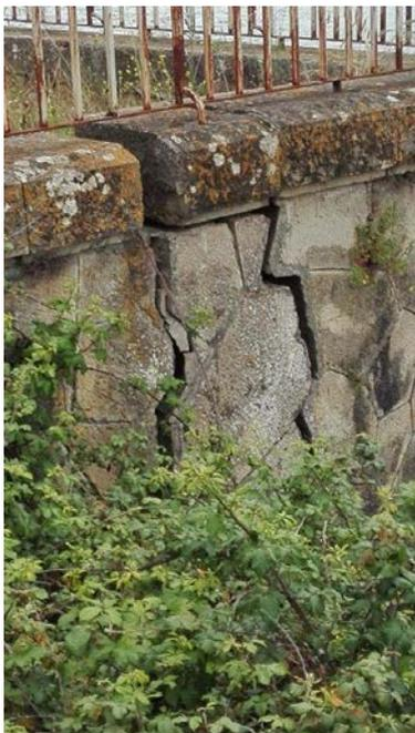
Figura 6 - Muro com fissuras, na zona a ser requalificada.
