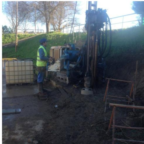
Figura 32 - Perfuração à rotação da S1\_AC.
