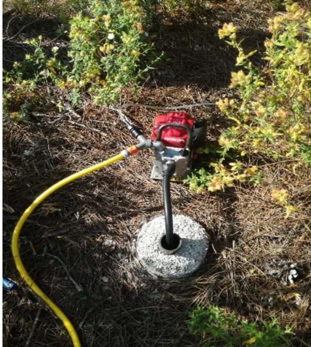
Figura 17 - Bomba utilizada para retirar água dos furos
