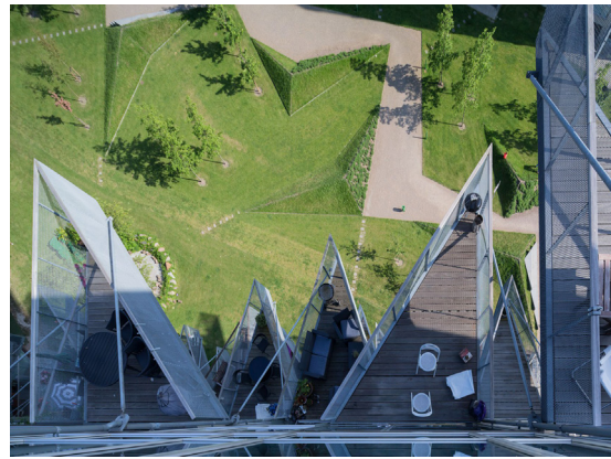
Fig. 90 _ Varandas triangulares do Bloco V
