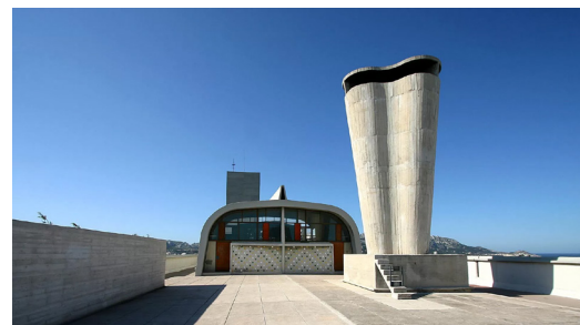
Fig. 73 _ Diversidade de equipamentos na cobertura
