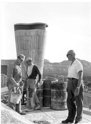
Fig. 96 _ Le Corbusier na cobertura
