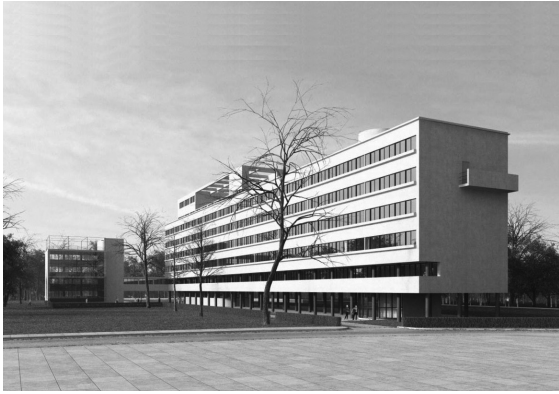
Fig. 54 _ Edifício Narkomfin de Moisei Ginzburg, Moscovo
