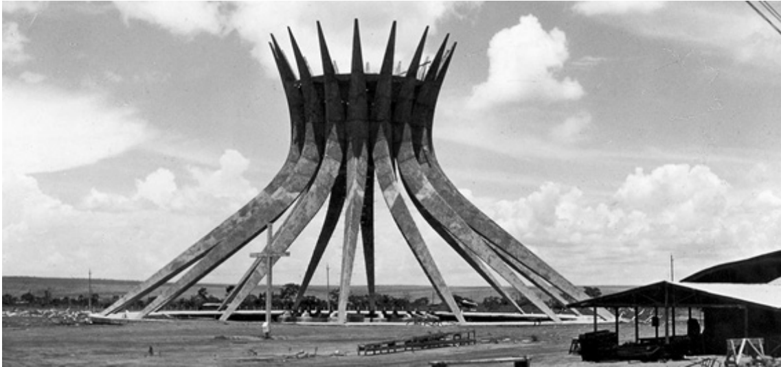
Fig. 31 _ Construção da Catedral de Brasília _ 1959
