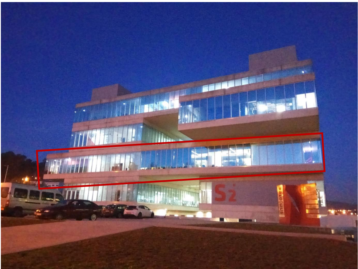
Figura 174 – Um dos edifícios da Sanjotec, em São João da Madeira, do arquiteto João Álvaro Rocha. A vermelho, o piso ocupado pela Creativesystems. Fotografia da autora, 2018.
