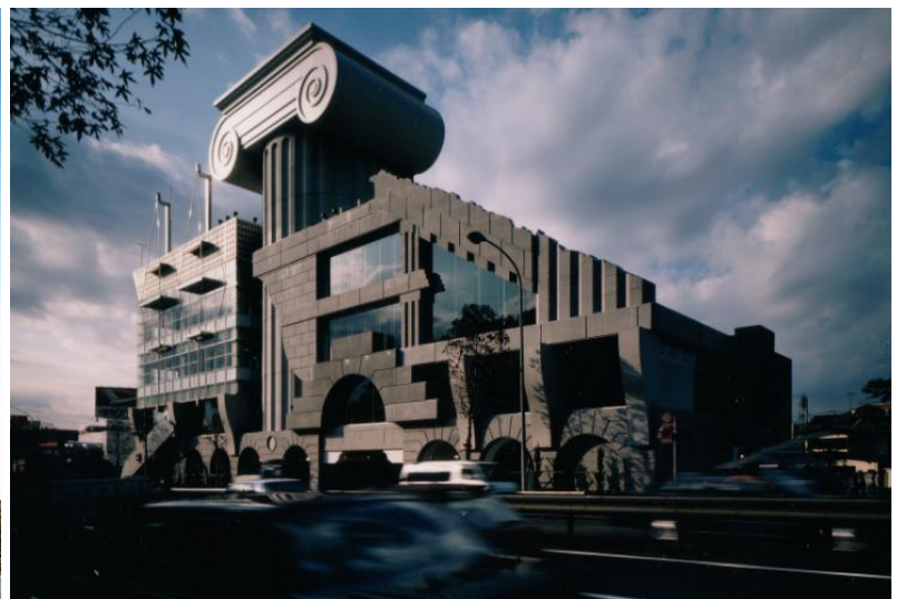
Figura 66 – Edifício M2, Tóquio.
