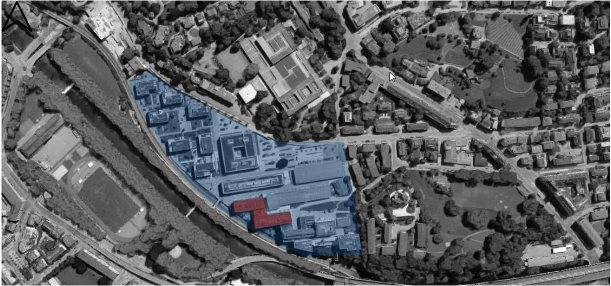
Figura 140 – Hürlimann Areal, Zurique, Suíça. A azul a área do parque; a vermelho o edifício da Google. Projeto de interiores do atelier Camezind Evolution, 2008.
