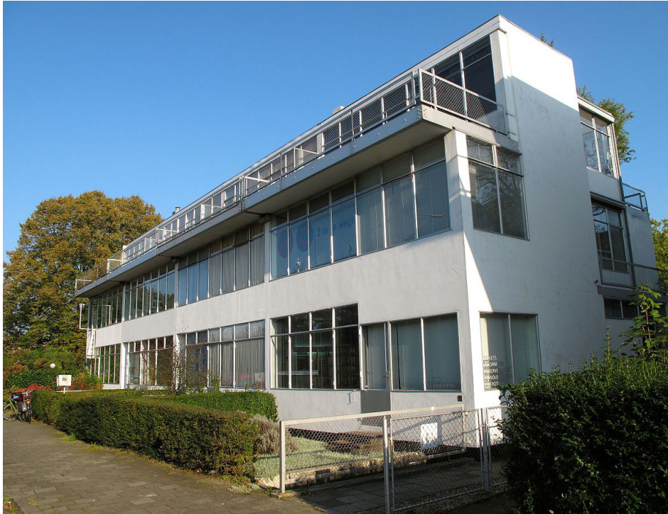
Figura 10 - Housing Block Erasmulaan de Gerrit Ritveld (1931) - foto do exterior.
