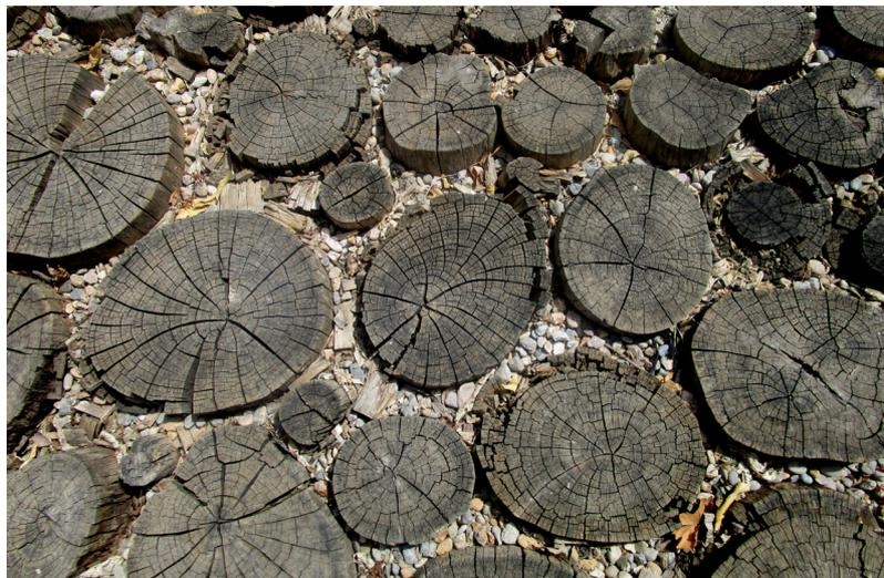
Figura 52 - Pavimento com troncos de eucalipto do exterior do Museu da Água de Lanjarón
