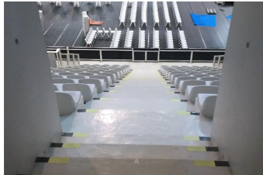
Figura 17 – Acesso de escadas
