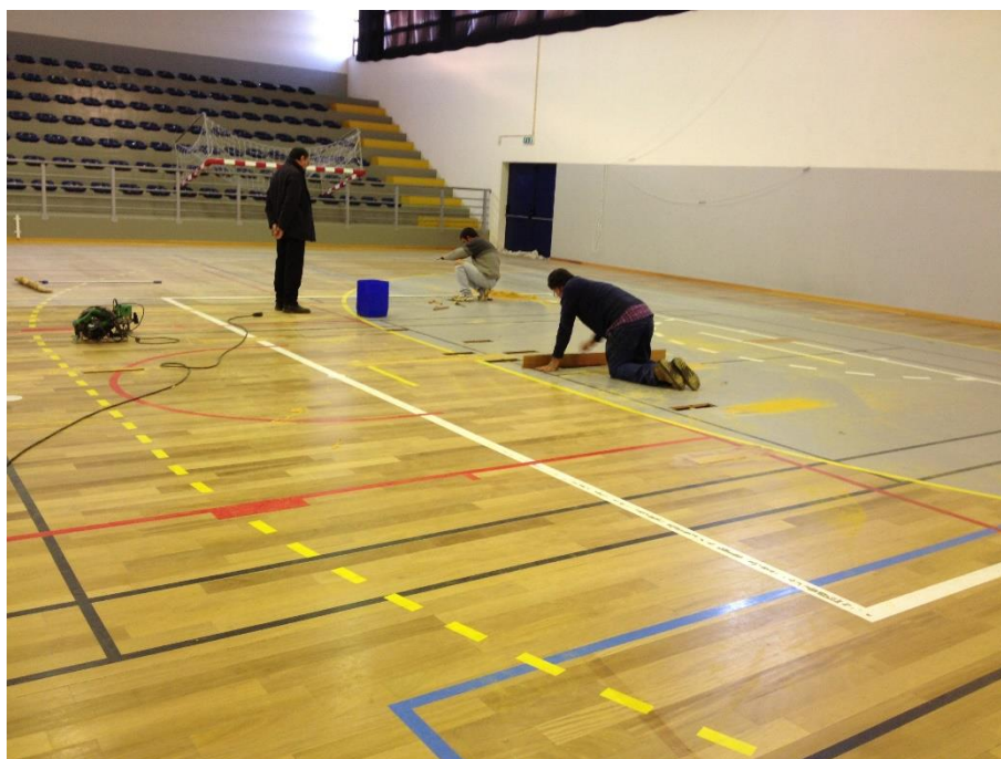
Figura E – Sobreposição de linhas em pavimento de madeira (Pavilhão Desportivo dos Pousos, Leiria)
