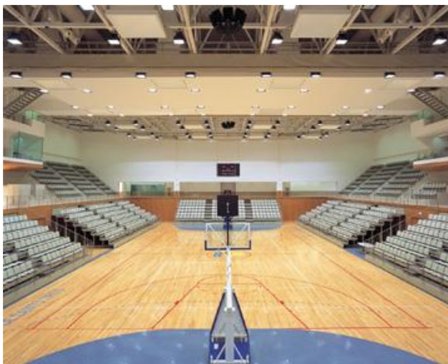
Figura R – Luminárias em foco dispostas ortogonalmente sobre o campo de jogo (Pavilhão Municipal de Santo Tirso, Santo Tirso)
