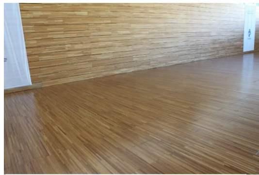
Figura 72 – Pavimento e topo
