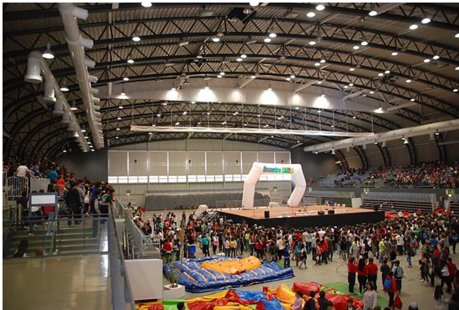
Figura T – Sistemas de ventilação, aquecimento e arrefecimento na cobertura (Portimão Arena, Portimão)
