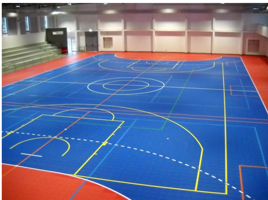
Figura F – Sobreposição de linhas em pavimento sintético (Escola Secundária Fernando Namora, Amadora)
