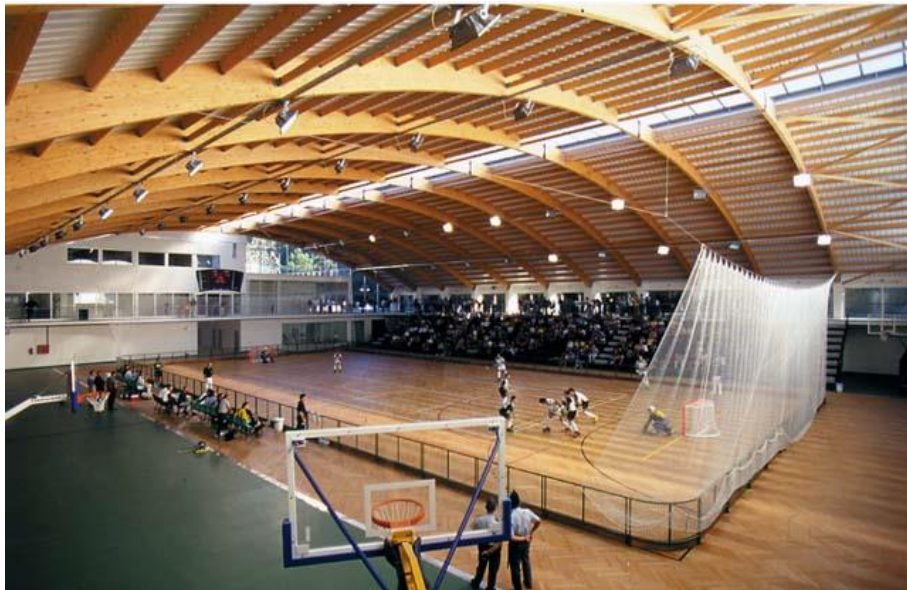
Figura Q – Luminárias em focos direcionados para o campo de jogo (Pavilhão Gimnodesportivo Municipal do Luso, Mealhada)
