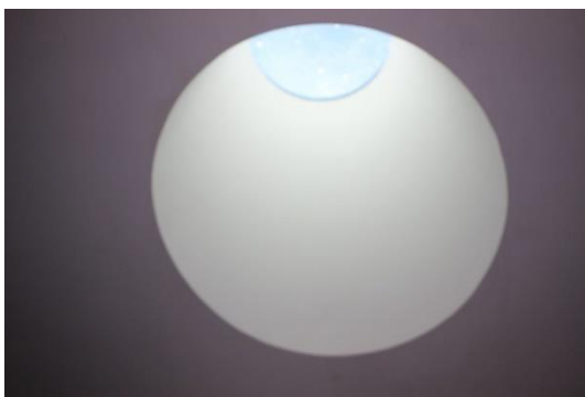
Figura 54 – Iluminação zenital (interior)
