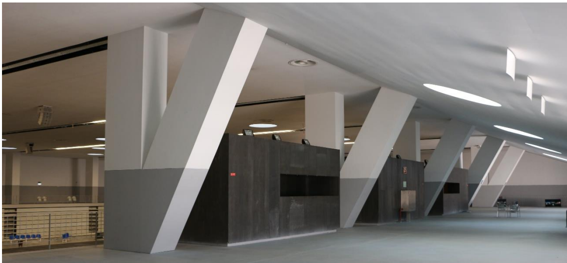
Figura 48 – Estrutura / zona de circulação / iluminação zenital
