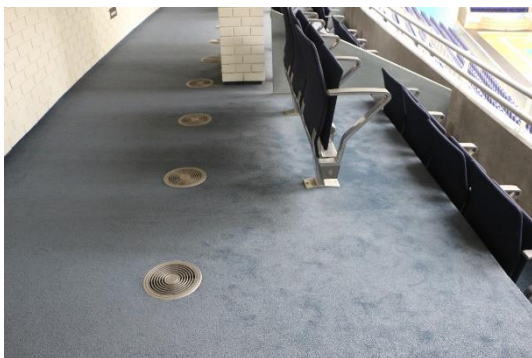
Figura 34 – Aquecimento de galeria
