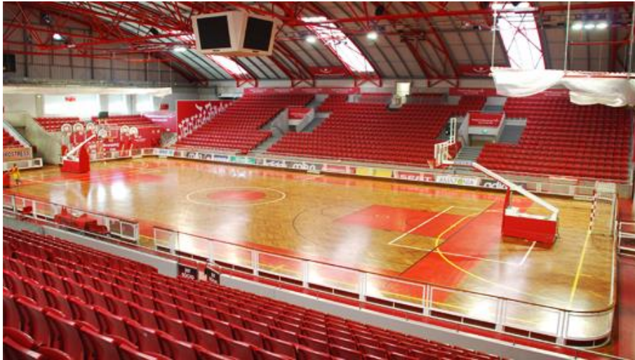
Figura U – Campo de jogo próximo das bancadas (Pavilhão Fidelidade, Lisboa)
