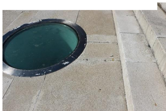
Figura 55 – Iluminação zenital (exterior)
