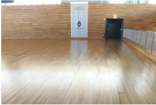
Figura 66 – Pavimento e topo
