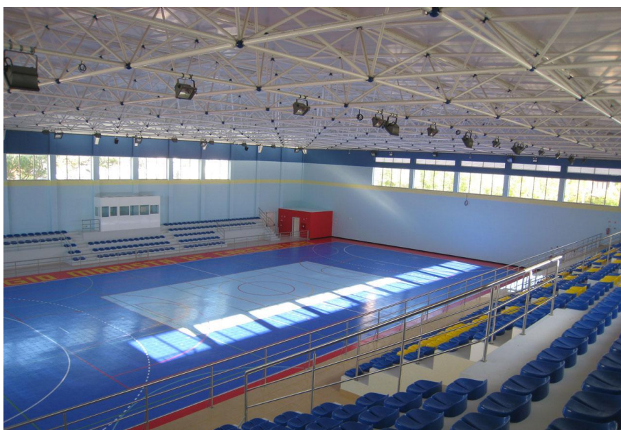
Figura O – Incidência solar direta no campo de jogo (Pavilhão Gimnodesportivo do Colégio dos Maristas, Carcavelos)
