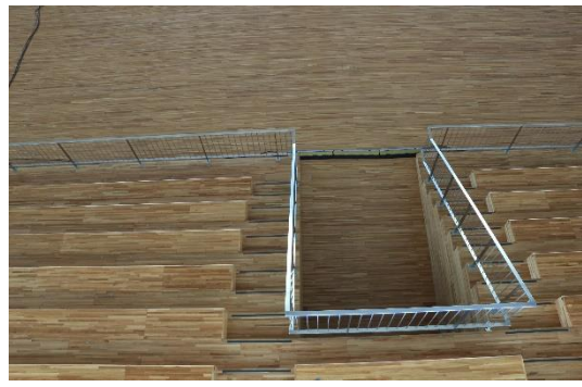
Figura 67 – Bancada e pavimento
