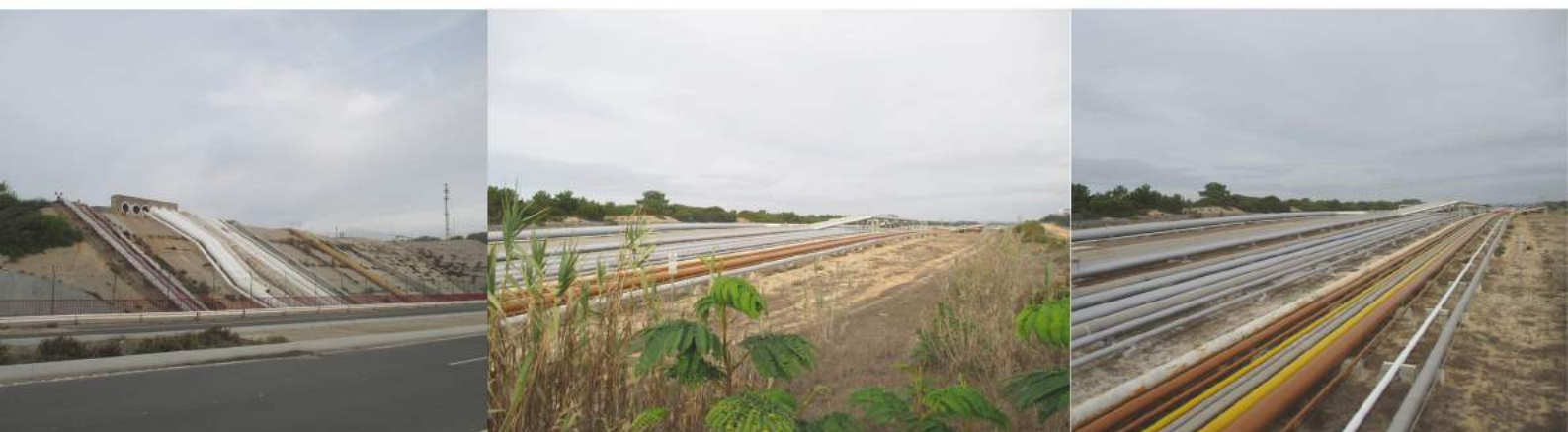
Fig.3 Infra-estruturas de distribuição de gases e de matérias-primas, que conectam com o Conjunto Industrial de Sines
