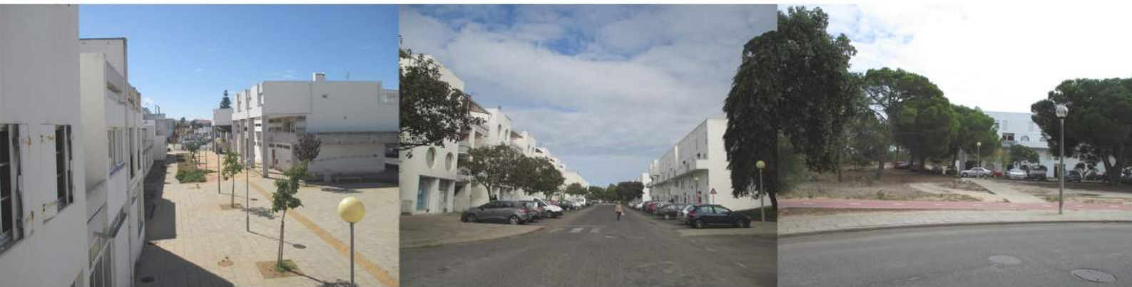
Fig.5 O estacionamento das habitações de Santo André e a relação com os pinhais
