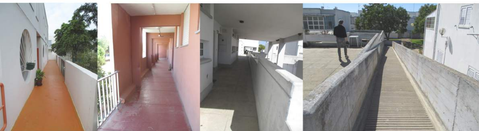
Fig.6 Galerias que criam uma entrada independente para os apartamentos do piso superiores
