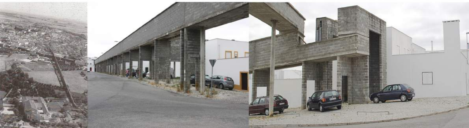
Fig.17 Vista aérea do aqueduto que liga ao Centro Histórico de Évora; Aqueduto assumindo diversas formas no Bairro da Malagueira
