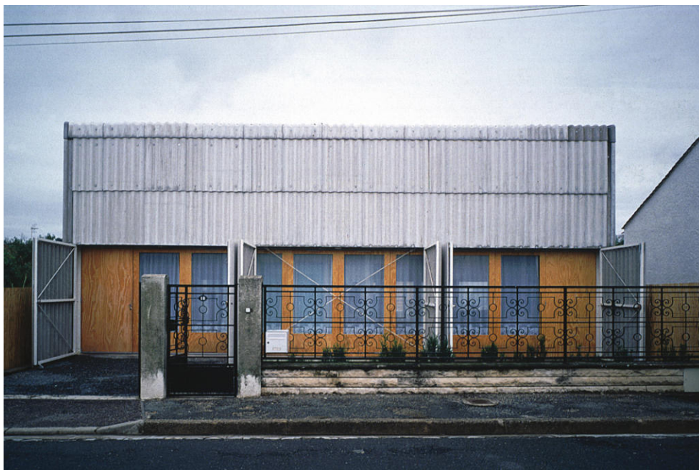
[figura 87] Fachada Oeste.
