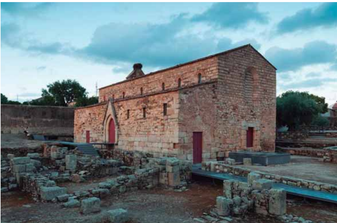
34. Igreja Matriz de Santa Maria de Idanha-a-Velha, após a recuperação.
