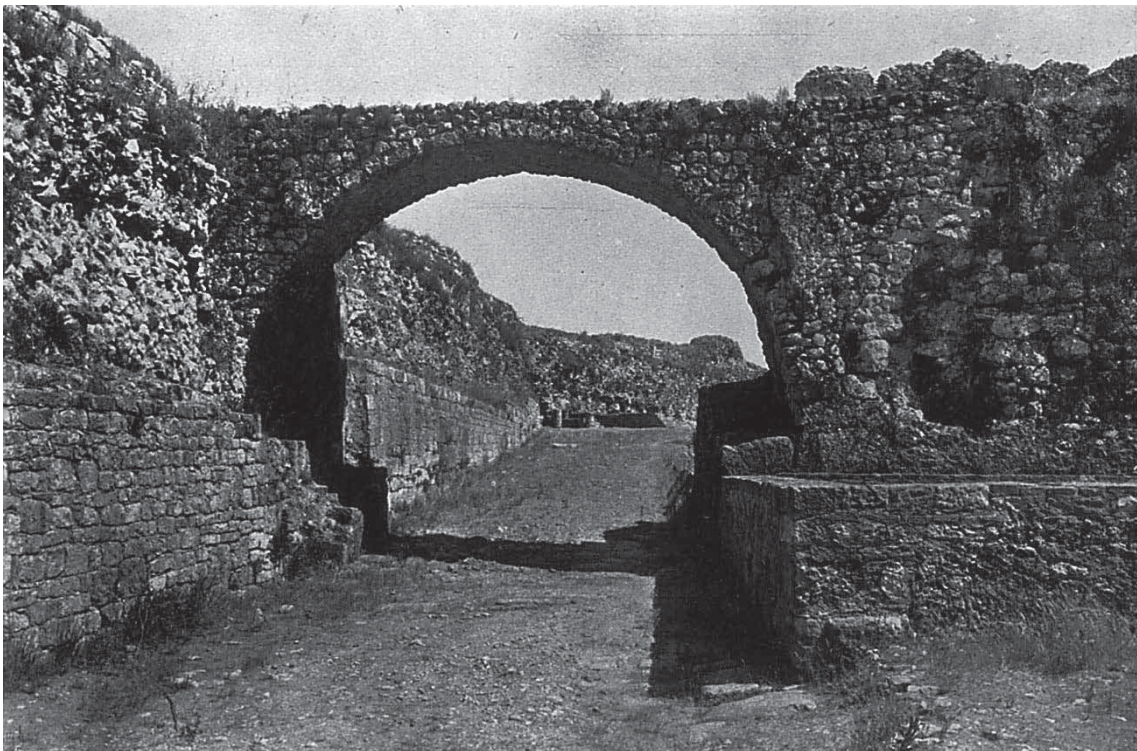
32. O mesmo aqueduto após os trabalhos de restauro do arco.
