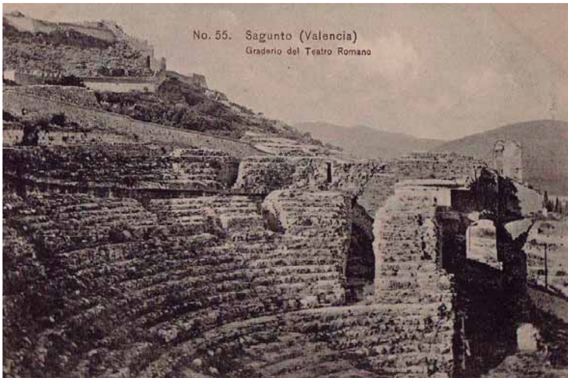
36. Teatro romano de Sagunto, antes ao projeto de restauro e reabilitação .
