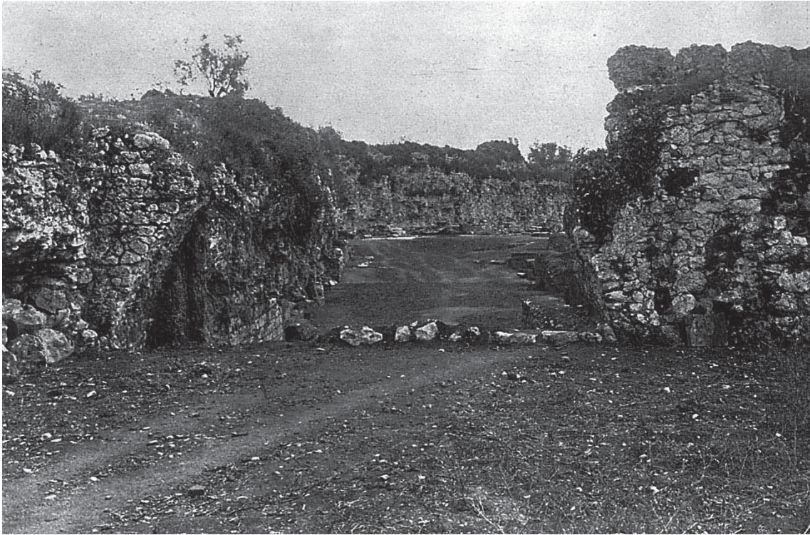
31. Aspeto da secção intramuros do aqueduto romano durante os trabalhos de escavação.
