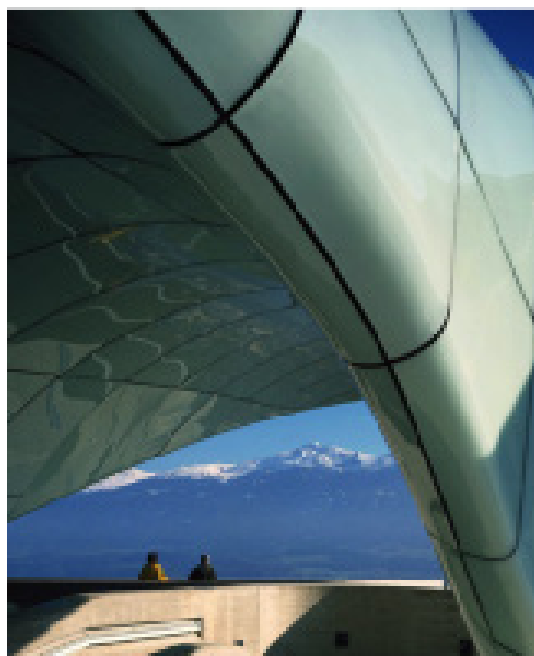
FIGURA 33 - Fotografia de construção do ponto de entrada que dá acesso à rampa de esqui de Innsbruck, na Áustria. | FIGURA 34 - Imagem computacional sobre o estudo do revestimento da pala que constitui o ponto de entrada — Pormenor das placas de titânio que o revestem. | FIGURA 35 - Pormenor da junção do material de revestimento.
