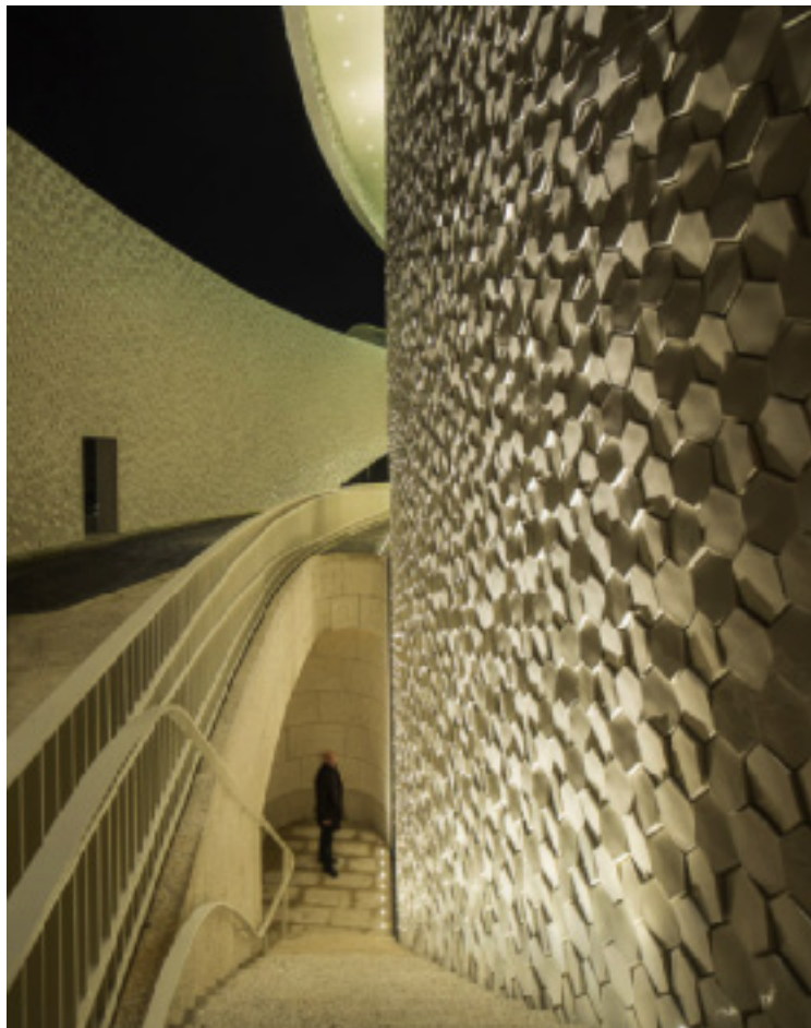
FIGURA 26 - Corredor de acesso a cruzeiros, pormenor de azulejo. | FIGURA 27 - Tambor central com azulejo destacado.
