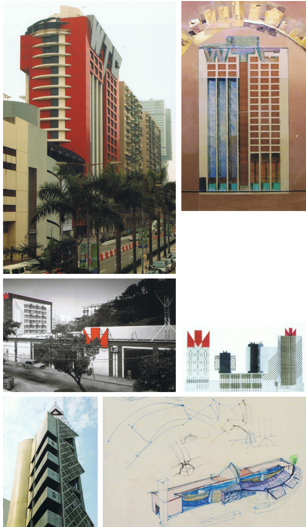
Figura 55 e 56. World Trade Center - WTC. Figura 57 e 58. Teledifusão de Macau - TDM. Figura 59 e 60. Quartel dos Bombeiros na Areia Preta.
