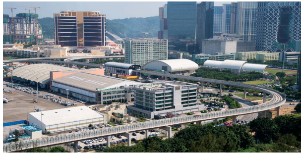
Figura 32. Segmento em construção do Metro Ligeiro.
