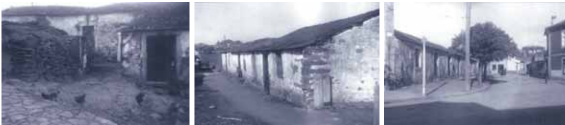
Figura 85, Figura 86 e Figura 87 Fotografias de habitações a demolir nas áreas I, II e VI, respectivamente.
