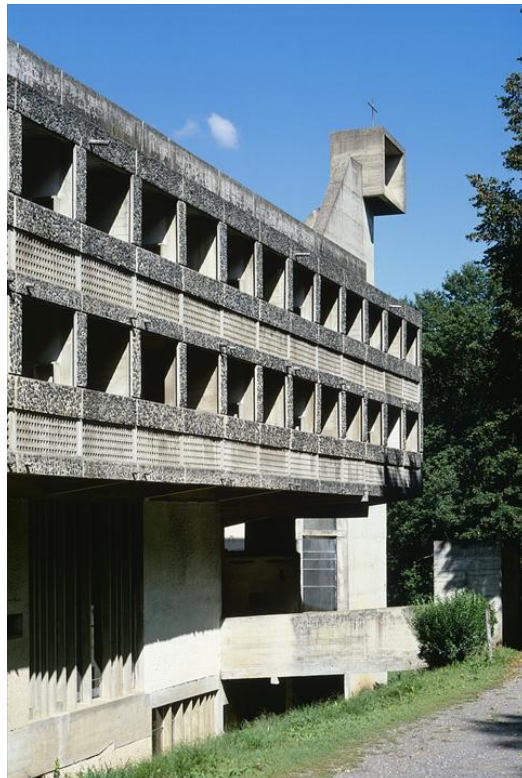
136. Interior do Convento de La Tourette. 1957-60, Lyon, França. Imagem apresentada no questionário a indivíduos que não visitaram os edifícios em análise.
