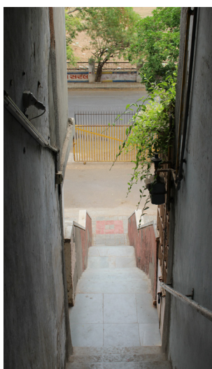
154. Acesso aos pisos superiores, Março de 2016.
