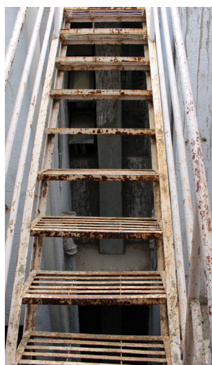
155. Acesso ao terraço e courette , Março de 2016.
