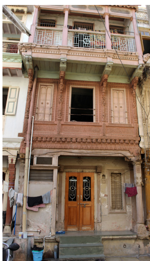
123. Habitação [3] Fachada Principal, Março de 2016.
