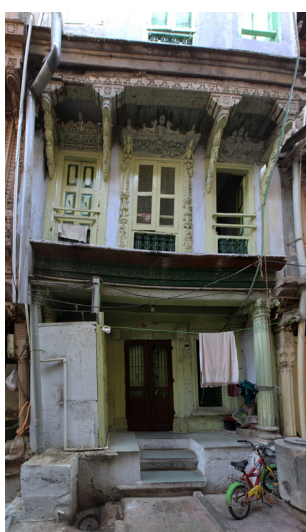
119. Habitação [2] Fachada Principal, Março de 2016.
