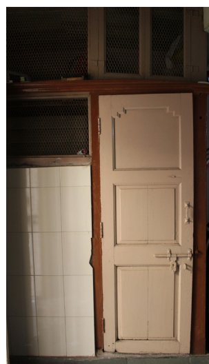
126. Habitação [3] Instalações Sanitárias, Março de 2016.
