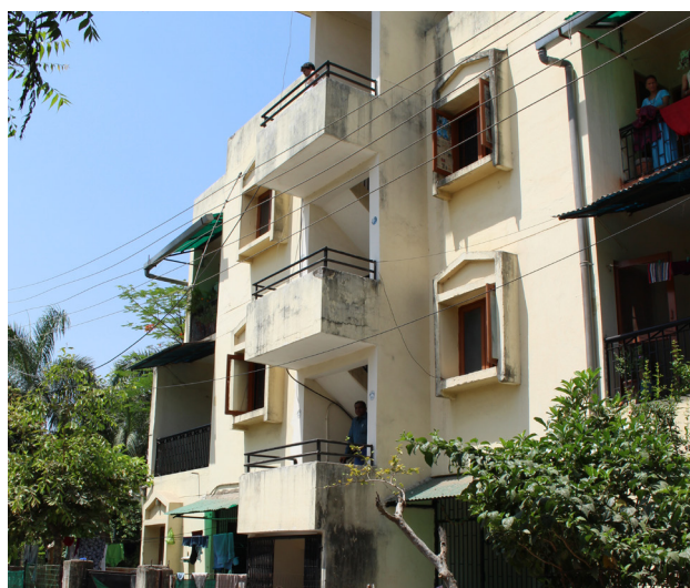
218. Edifício de Apartamentos para a classe média (MIG), Abril de 2016.
