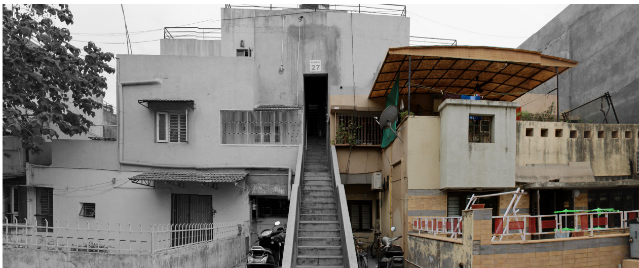
175. Fachada da Habitação [2] e [3], Abril de 2016.
