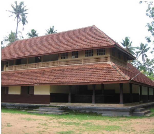
84. Nalukettu , casa-pátio típica do Estado de Kerala, Índia.
