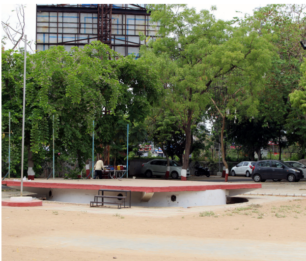
142. Depósito de água, Março de 2016.
