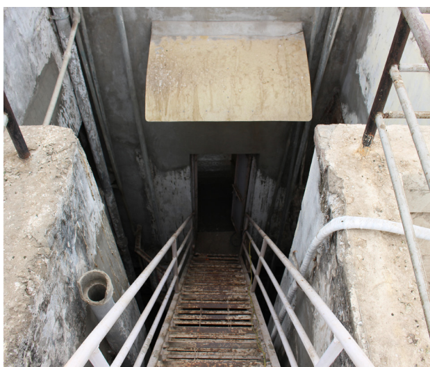
156. Acesso ao terraço e courette , Março de 2016.
