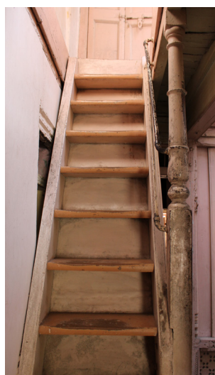
125. Habitação [3] Escadas interiores, Março de 2016.
