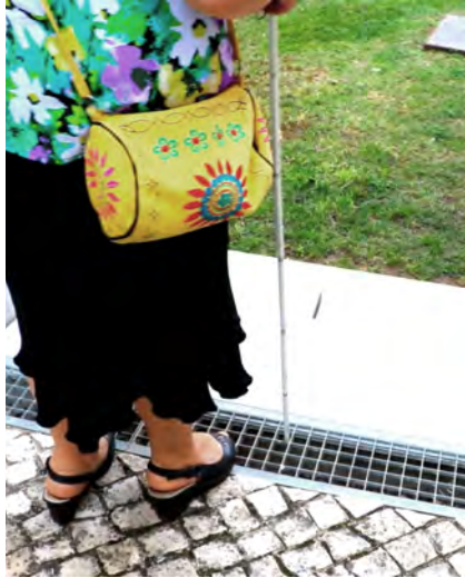
167 | Grelha metalizada para o exterior, Conservatório de Música de Cascais
