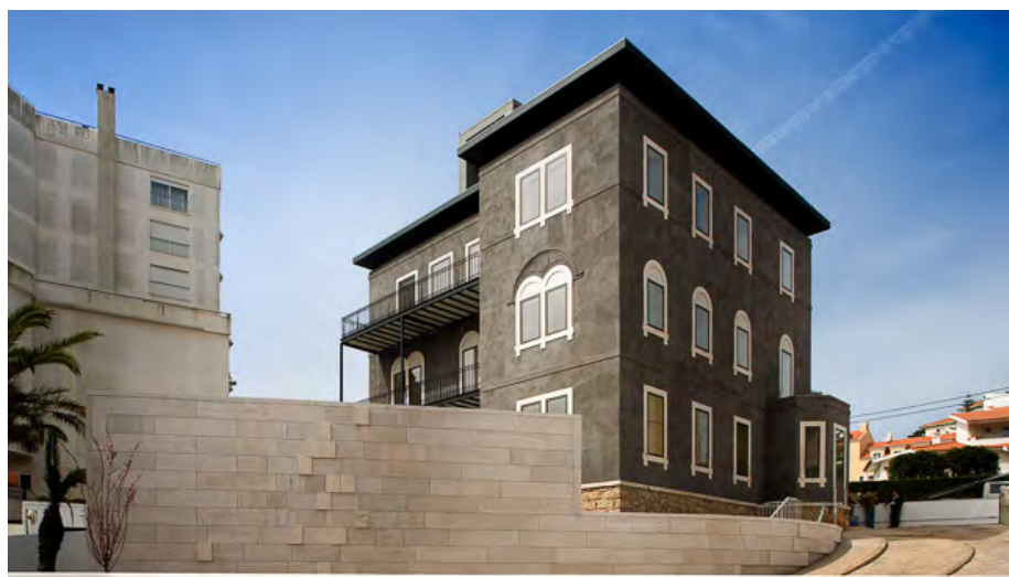
67 | Fachada Principal, Conservatório de Música de Cascais
