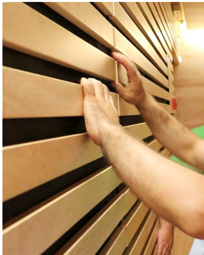
121 | Detalhe da parede de fundo do Auditório Principal, Conservatório de Música de Coimbra
