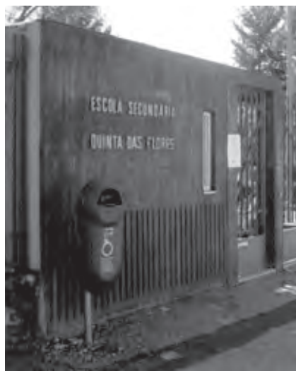
98 | Frente Rua, antes da reabilitação, Conservatório de Música de Coimbra
