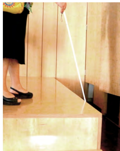
88 | Palco, da sala polivalente, Conservatório de Música de Cascais
