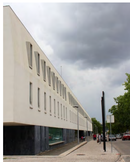
99 | Frente Rua, depois da reabilitação, Conservatório de Música de Coimbra
