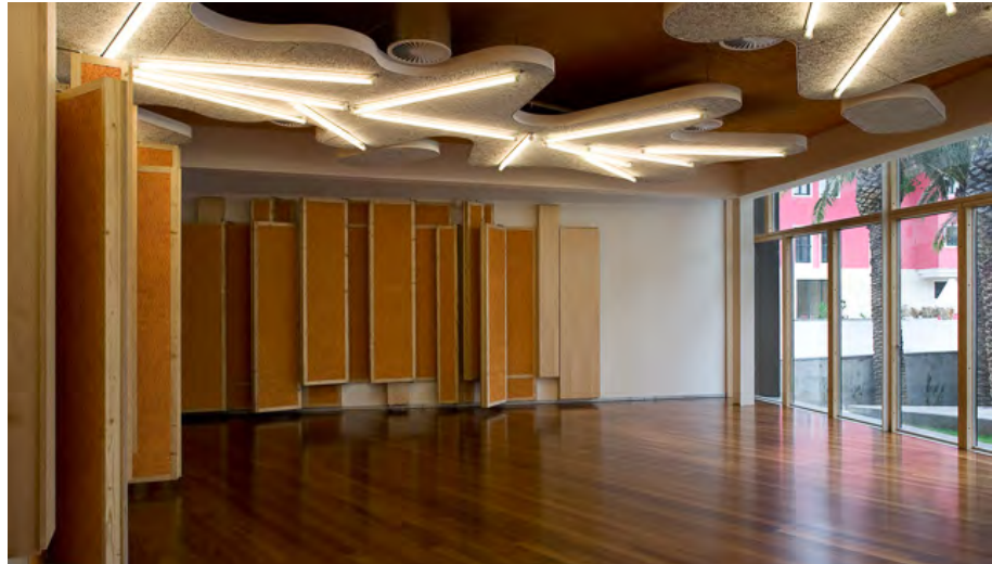
90 | Sala Polivalente, pormenor das placas de madeira revestidas com fibras de madeira, Conservatório de Música de Cascais
