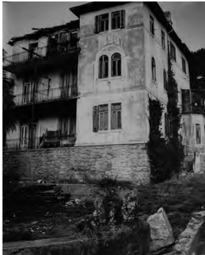
53 | Chalet Madalena- Conservatório de Música de Cascais, antes da reabilitação
