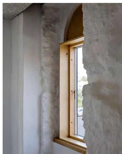
71 | Detalhe da parede, depois da reabilitação, Conservatório de Música de Cascais
