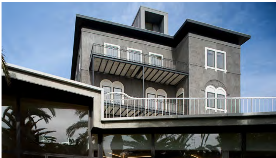
64 | Exterior do Conservatório de Música de Cascais. Ponto de Vista do jardim
