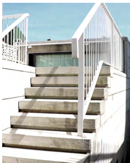
92 | Escadas de acesso ao terraço, Conservatório de Música de Cascais
