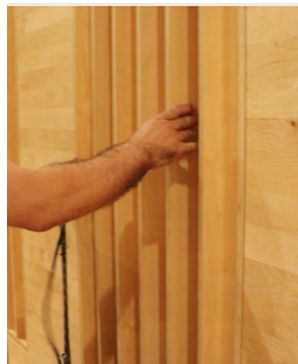
122 | Detalhe da parede lateral da plateia do Auditório Principal, Conservatório de Música de Coimbra
