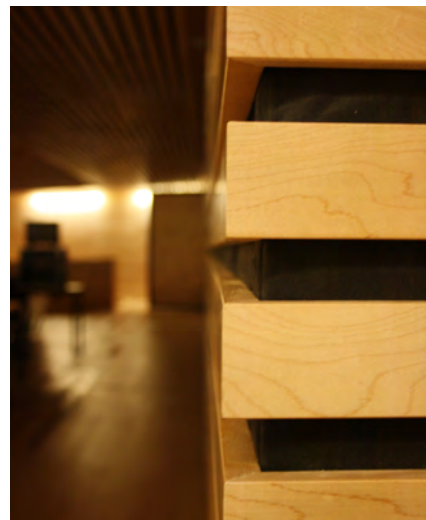
111 | Detalhe da parede lateral do Auditório Principal, Conservatório de Música de Coimbra
