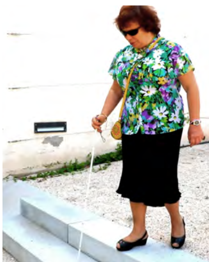
96 | Diferença de pavimentos, Conservatório de Música de Coimbra
