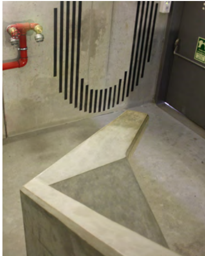
124 | Remate das escadas, Conservatório de Música de Coimbra
