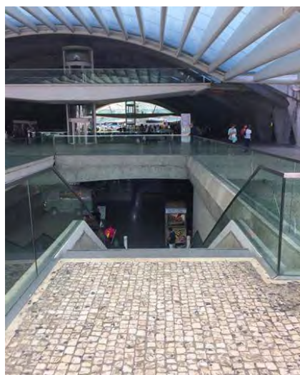
25 | Acesso às escadas ao piso subterrâneo, na Gare do Oriente
