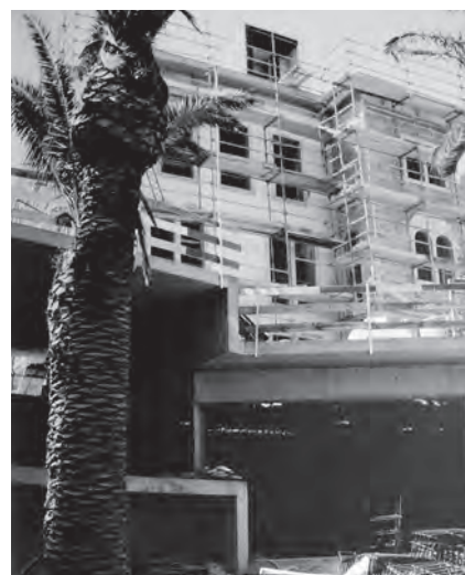
59 | Exterior do Conservatório de Música de Cascais, durante a fase de obras
