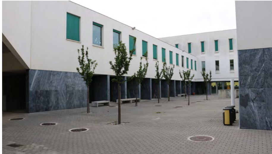
132 | Exterior, Conservatório de Música de Coimbra
