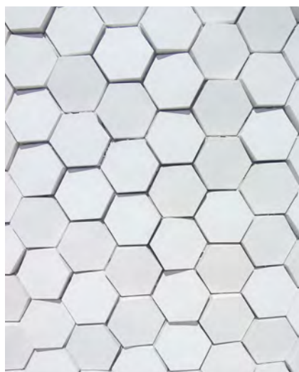
144 | Azulejos hexagonais que revestem as paredes, Terminal de Cruzeiros do Porto de Leixões
