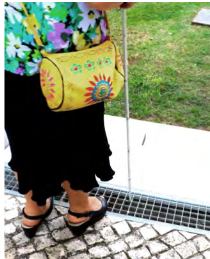
95 | Grelha existente, antes dos degraus exteriores de acesso ao jardim, Conservatório de Música de Coimbra
