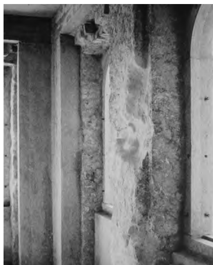
70 | Detalhe da parede, antes da reabilitação, Conservatório de Música de Cascais
