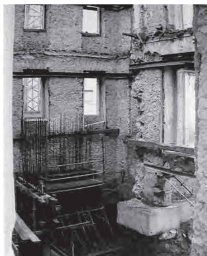
58 | Interior do Conservatório de Música de Cascais, durante a fase de obras
