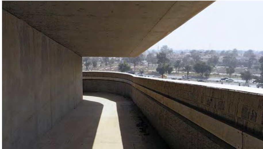
159 | Promenade Architectural. Le Gymnase de Le Corbusier
