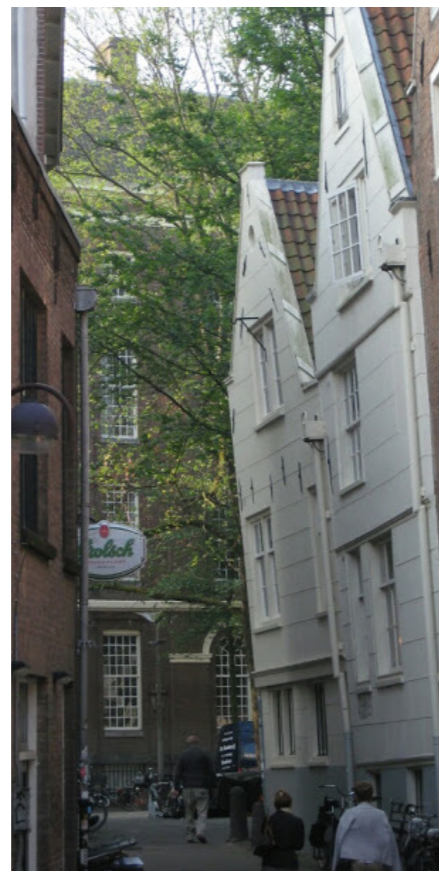
51. Fachada inclinada, Amesterdão
