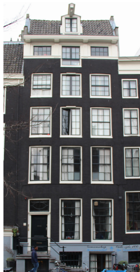
34. Fachada de habitação com grandes vãos, Amesterdão
