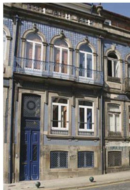
24. Entrada à cota da rua com elevação interior, Porto, Portugal
