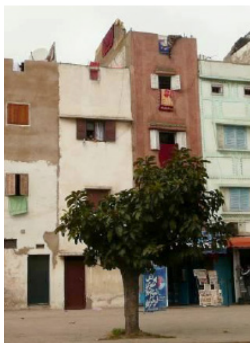
Figura 63 - Rua habitacional, Hay Hassani
