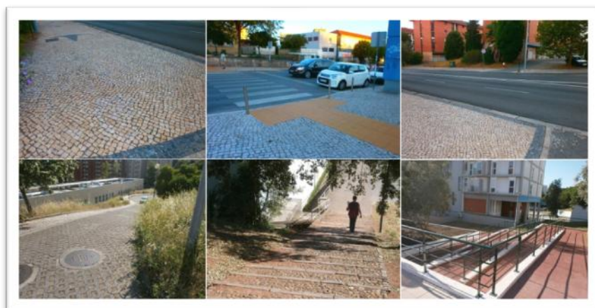
Imagem 22: Ruas, calçadas e acessos da "Solum".
