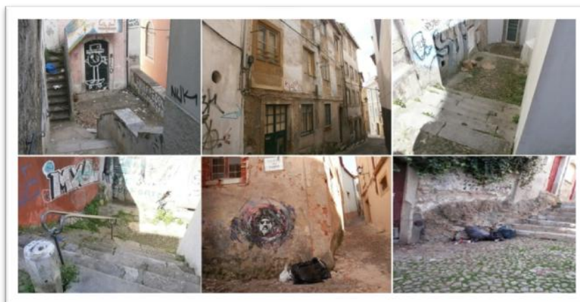
Imagem 16: Sujeira e má conservação.
