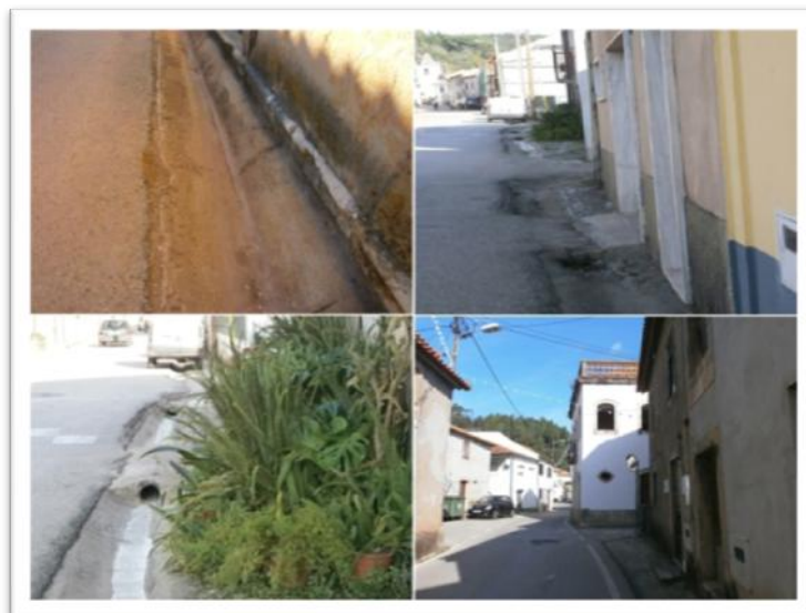
Imagem 30: Valas e desníveis para escoamento de águas pluviais no "Botão".
