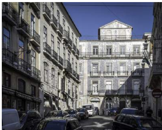
Figura 7. Fachada do prédio erguido no sítio da igreja edificada pós-terramoto. José Vicente, 2013, DPC – CML
