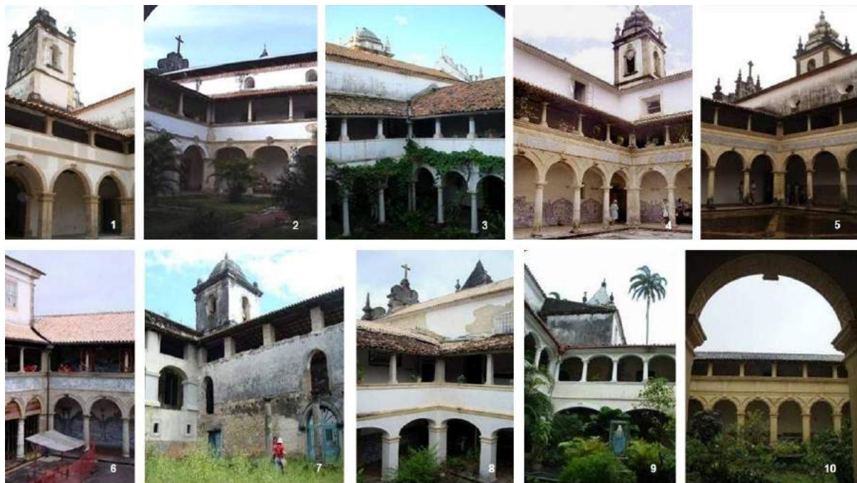
Figura 5. Em ordem, os claustros dos conventos de Marechal Deodoro (1), Penedo (2), Ipojuca (3) e Recife (4), João Pessoa (5), Salvador (6), Paraguaçu (7), Cairú (8), São Francisco do Conde (9), São Cristóvão (10)
