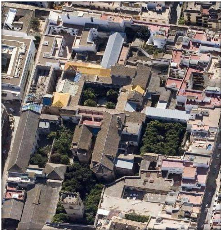
Figura 7. El Real Monasterio de Santa Clara una vez exlastrado. Obras en sus dormitorios para adaptación a uso cultural y restauraciones en el claustro principal
