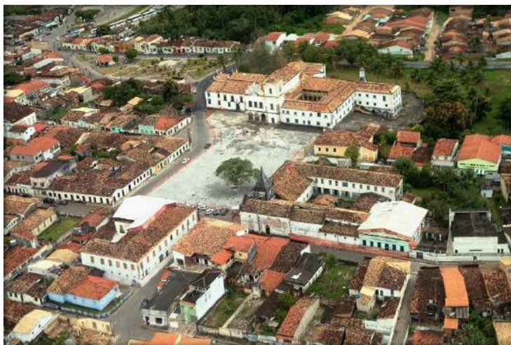
Figura 6. Convento do Bom Jesus de São Cristóvão. Vista aérea
