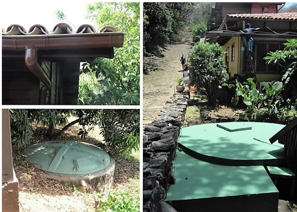
Fotografias 24 - Sistemas de recolha e armazenamento de água da chuva em várias pousadas em Fernando de Noronha, Brasil.
