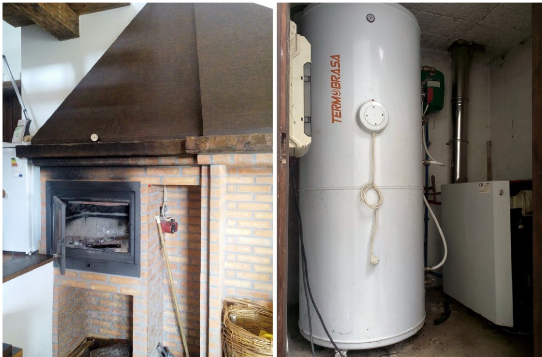
Fotografias 7 - Exemplo de lareira com sistema para aquecimento de águas sanitárias em hotel no Centro de Portugal.
