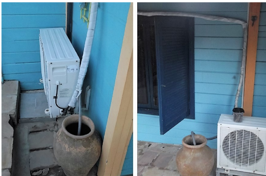
Fotografias 23 - Recolha da água expelida pelo sistema de ar condicionado numa Pousada em Fernando de Noronha, Brasil
