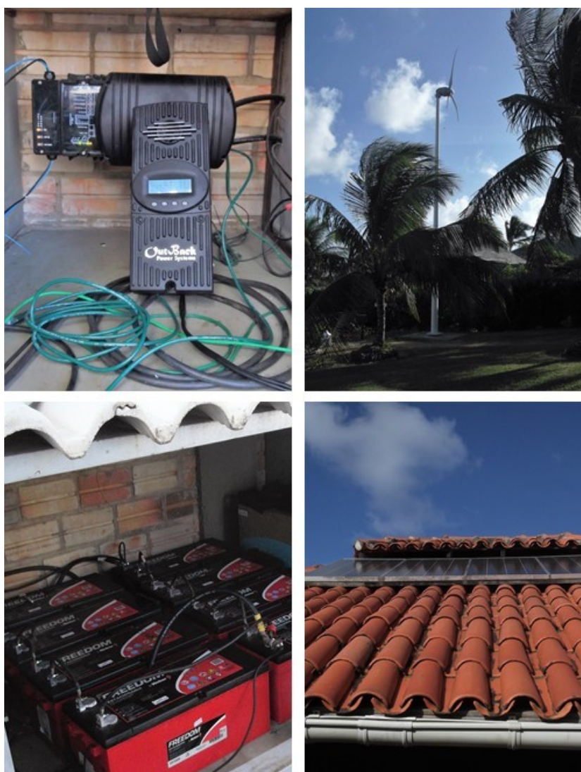
Fotografias 13 - Sistema de gestão integrada de fontes de energia numa Pousada no Estado de Pernambuco, Brasil.
