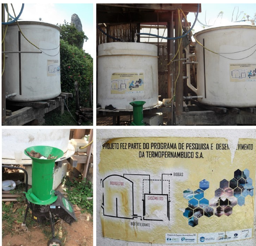
Fotografias 26 - Sistema para produção de biogás a partir de resíduos orgânicos numa Pousada em Fernando de Noronha, Brasil.
