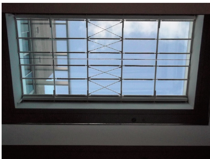
Fotografia 11 - Claraboia para iluminação natural em hotel na Paraíba, Brasil.
