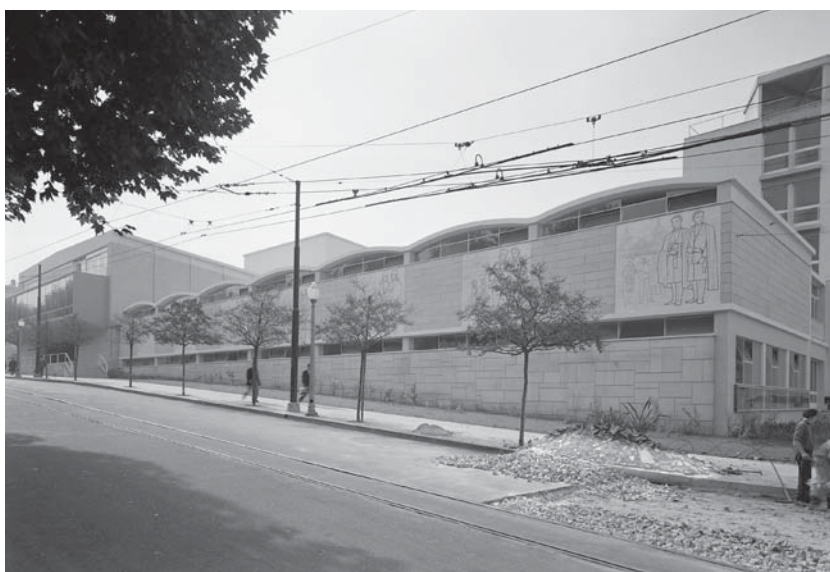
Figura 5.3. Vista exterior das Instalações Académicas. Acesso ao edifício da sede e ala dos ensaios. Foto de Horácio Novais.
