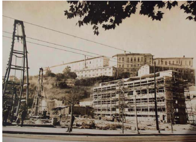
Figura 5.14. Corpo I em construção.
