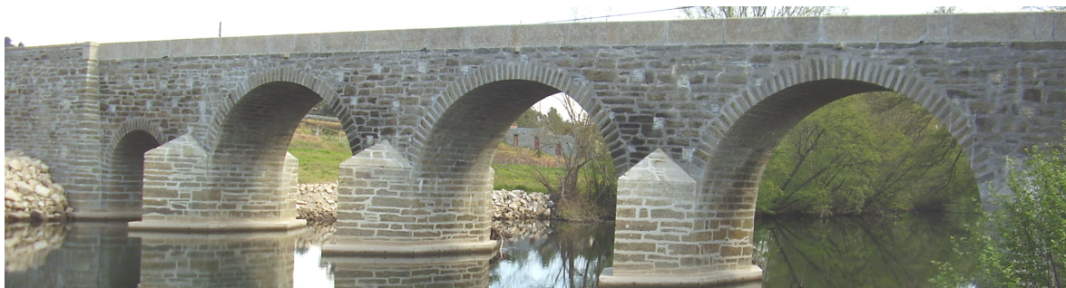
Figura 1-1: Ponte da Formigosa (vista de jusante).
