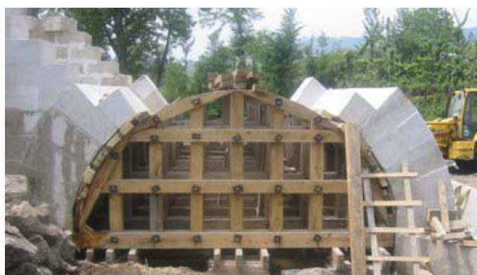
Figura 1-2: Construção de um arco da Ponte de Vila Fria. Figura retirada de (ARÊDE 2005).
