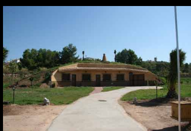
Fig. 06 – Biovivienda, Villa Nueva de las Torres
