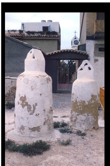
Fig. 27 – Chaminés: elementos que denunciam esta arquitectura subterrânea, "Cuevas de Buenavista", Paterna
