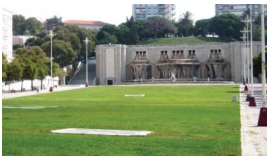
FIG. 58 Fonte Luminosa, elemento de remate a Av. Afonso Henriques
