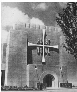
FIG. 91 Pavilhão da "Fundação", de Rodrigues da Lima
