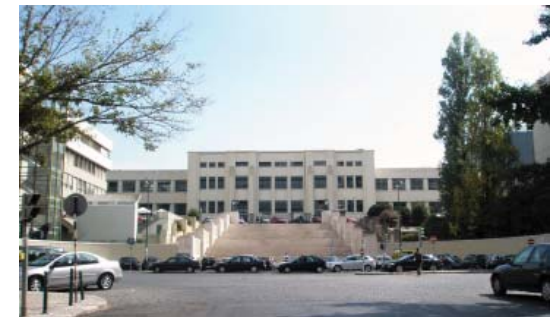
FIG. 62 Entrada Secundário do Instituto Superior Técnico
