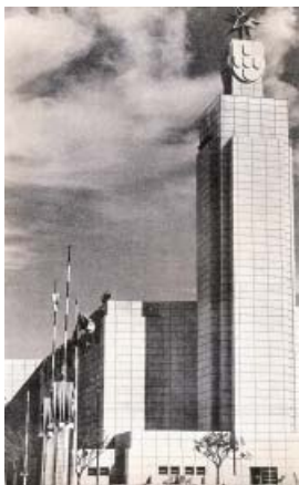
FIG. 99 Fachada virada para o rio Tejo, do "Pavilhão dos Portugueses no Mundo", de Cottinelli Telmo
