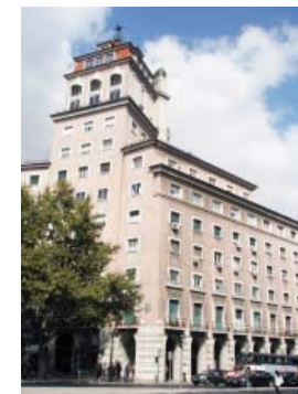
IG. 70 Torre Central da Praça do Areeiro
