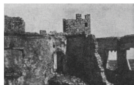
FIG. 17/18 Castelo de Óbidos, Alcaçova, antes e depois da intervenção da DGEMN
