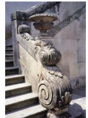
FIG. 37 Pormenor da escadaria da casa do Eng. Ricardo Severo (1900), no Porto
