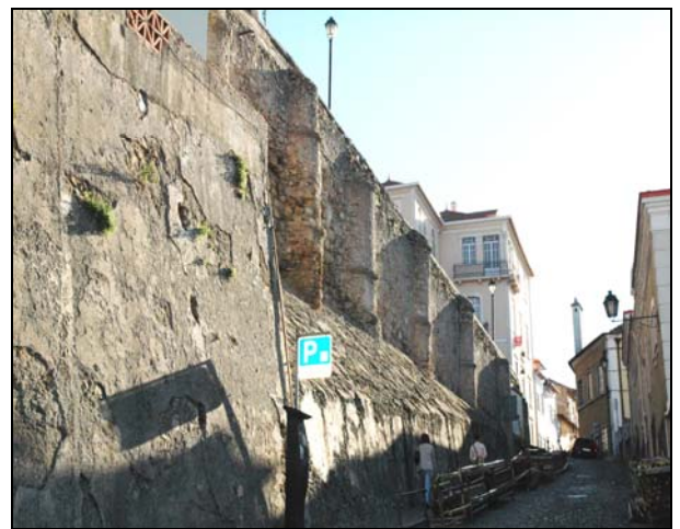
Tramo Inferior - Vista geral após retirada de grande parte das herbáceas.
