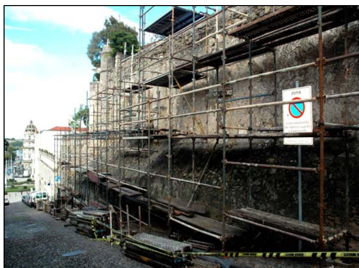
Montagem de andaimes, de rede de protecção e da vedação do estaleiro nos troços superior e inferior da Muralha
