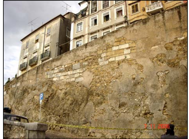
Tramo Superior - Paramentos com juntas desguarnecidas, reboco degradado em certas zonas e ausente noutras.
