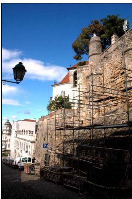
Montagem de andaimes, de rede de protecção e da vedação do estaleiro nos troços superior e inferior da Muralha
