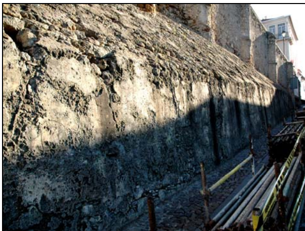
Tramo Inferior - Reboco em avançado estado de degradação em algumas zonas e totalmente ausente noutras.
