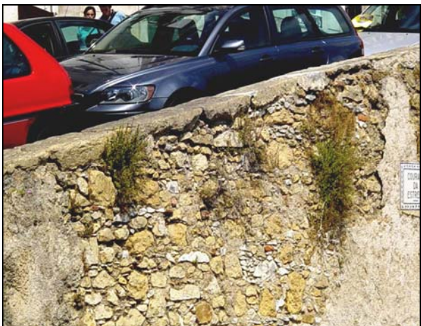
Tramo Superior - Infestações de espécies herbáceas, juntas desguarnecidas, ausência de reboco, utilização de pedras calcárias de baixa resistência bastante fragilizadas pela sua exposição a agentes externos, cantarias com vestígios de colonização biológica e alguns volumes repostos com argamassas de cimento.
