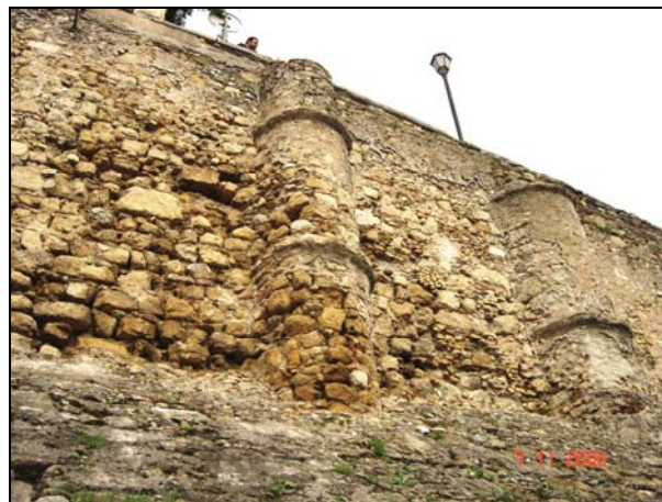
Tramo Inferior - Reboco em avançado estado de degradação em algumas zonas e totalmente ausente noutras.
