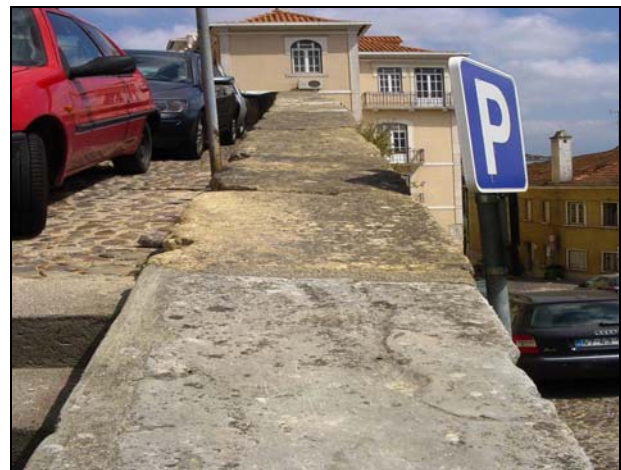
Tramo Superior - Infestações de espécies herbáceas, juntas desguarnecidas, ausência de reboco, utilização de pedras calcárias de baixa resistência bastante fragilizadas pela sua exposição a agentes externos, cantarias com vestígios de colonização biológica e alguns volumes repostos com argamassas de cimento.
