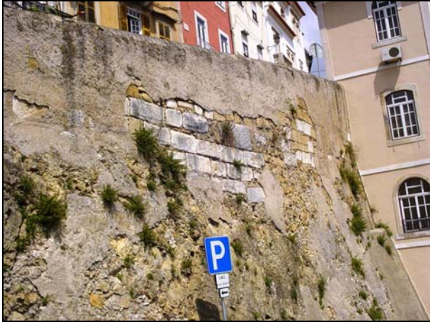
Tramo Superior - Paramentos com juntas desguarnecidas, reboco degradado em certas zonas e ausente noutras.
