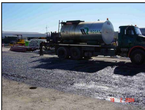
Aplicação da rega de impregnação
