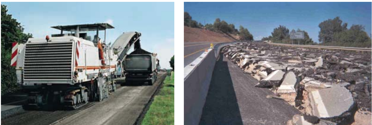
Figura 6.3 – Fresagem de camadas de pavimento e placas de pavimento (Ibarra, 2003)
